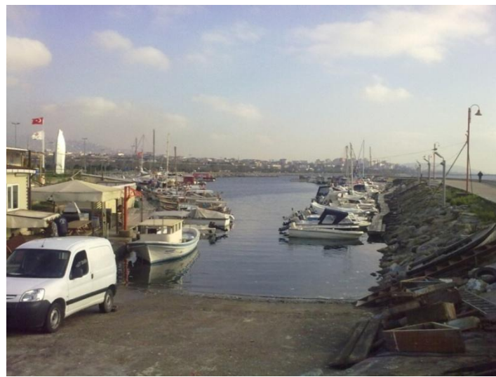
Şekil 3.22: Küçükalyalı Balıkçı Barınağı
