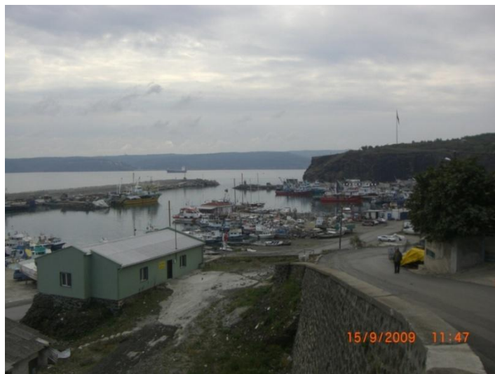
Şekil 3.25: Rumeli Feneri Köyü Balıkçı Barınağı
