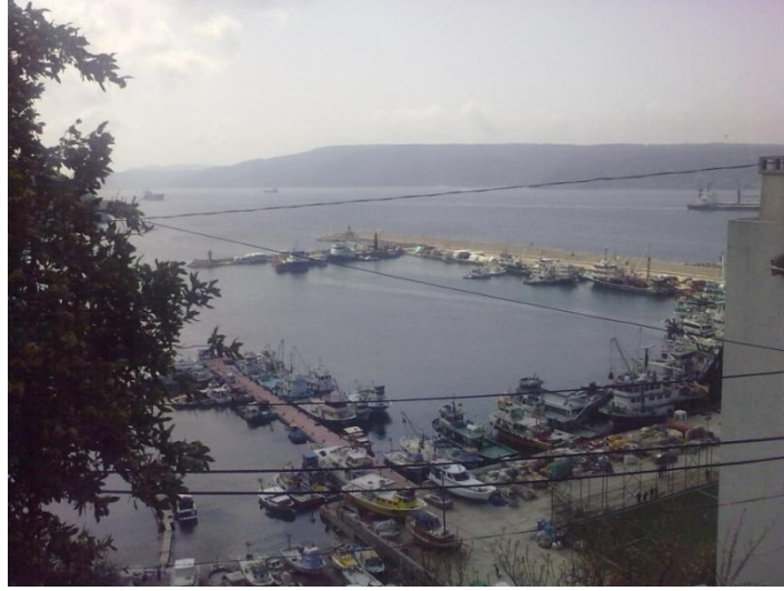
Şekil 3.24: Poyrazköy Balıkçı Barınağı
