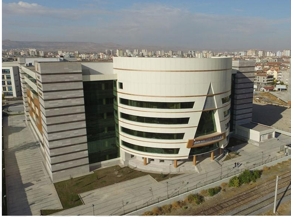
Şekil 3.1. Kayseri Vergi Dairesi Başkanlığı Binası
