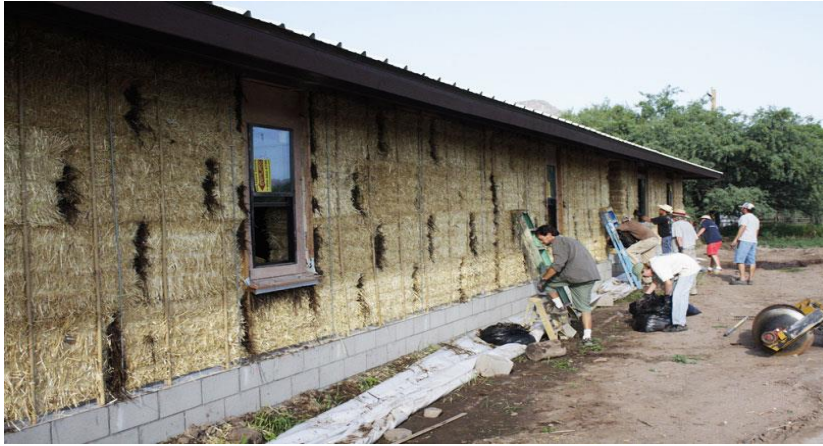
Şekil 2.7: Saman Balyalarından Yapılan Yalıtım Çalışmaları
