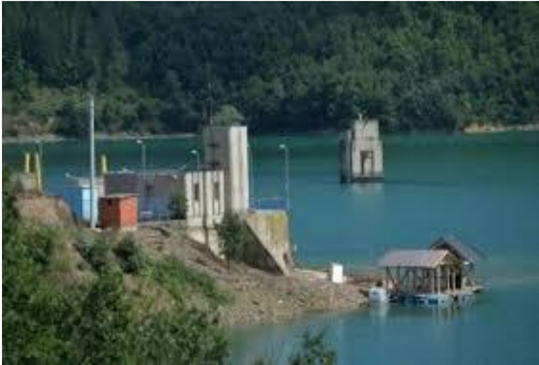
Şekil 2.3. Gazivoda Gölü'ndeki hidroelektrik santrali (Google Earth, 2020)
