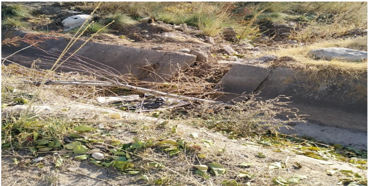
Şekil 3.9. Sağ sahil yedek 1 kanalı
