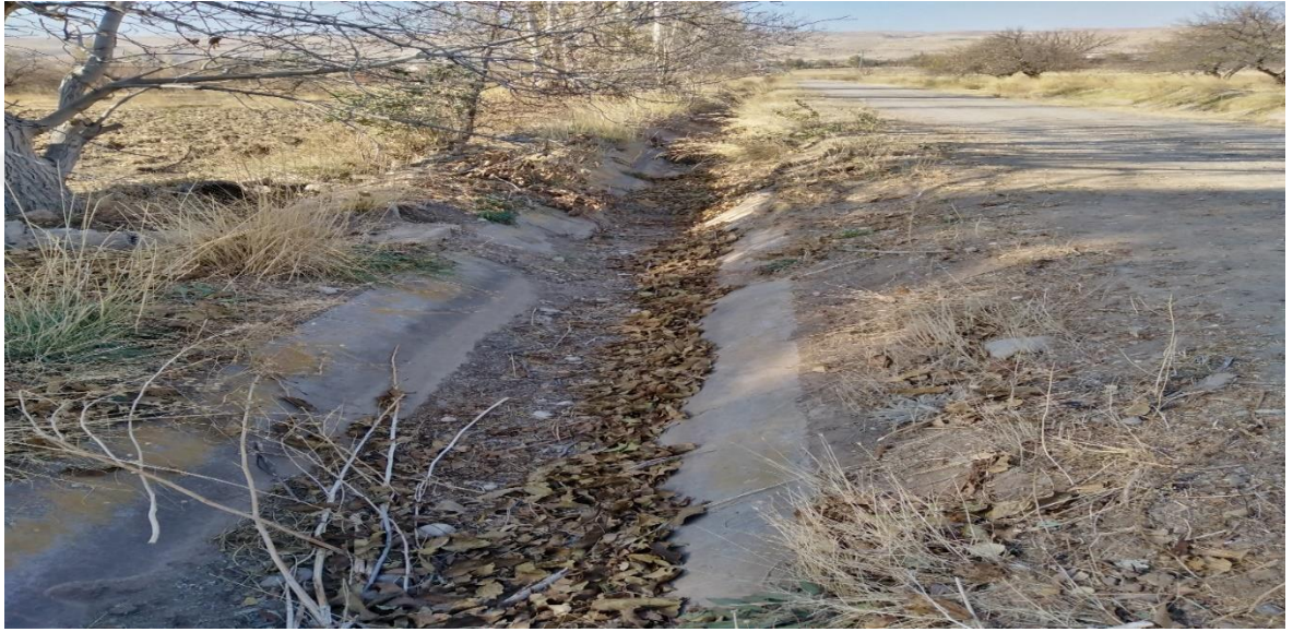
Şekil 3.8. Sağ sahil yedek 1 kanalı
