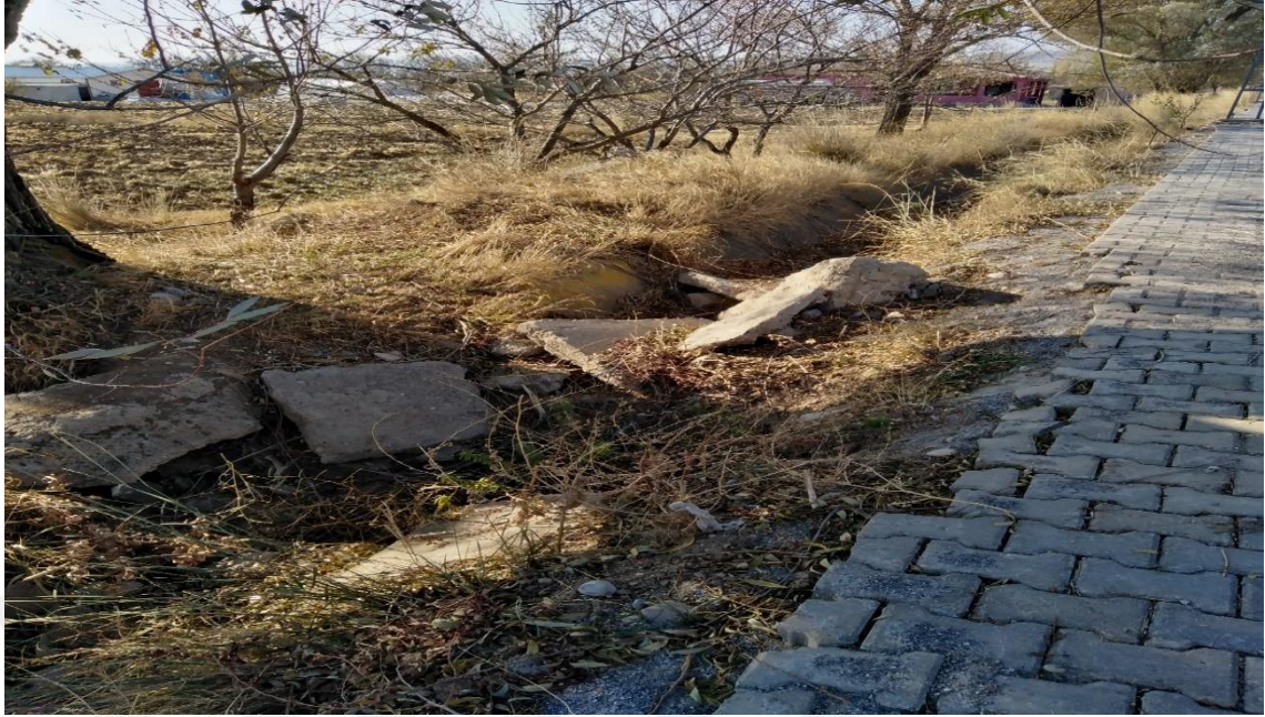
Şekil 3.10. Sağ sahil yedek 1 kanalı
