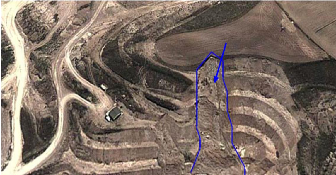
Şekil 6.41. İnceleme alanında meydana gelen şev kayması
