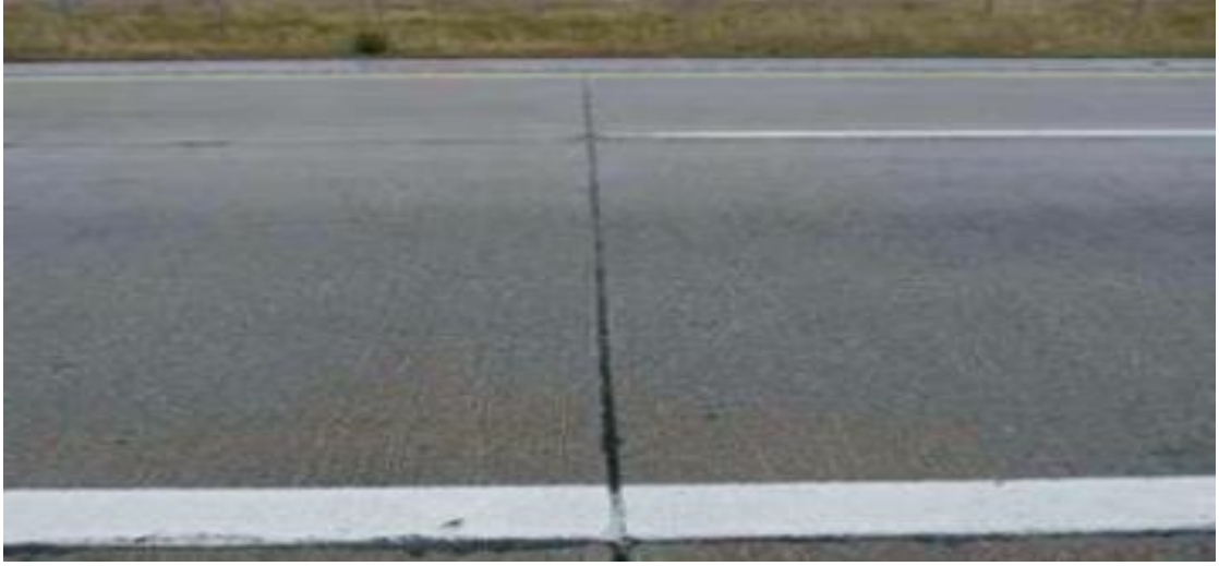
Şekil 20. Bölüm A ile E arası tipik bir enine derz (derzlerde herhangi bir problem yoktur)
