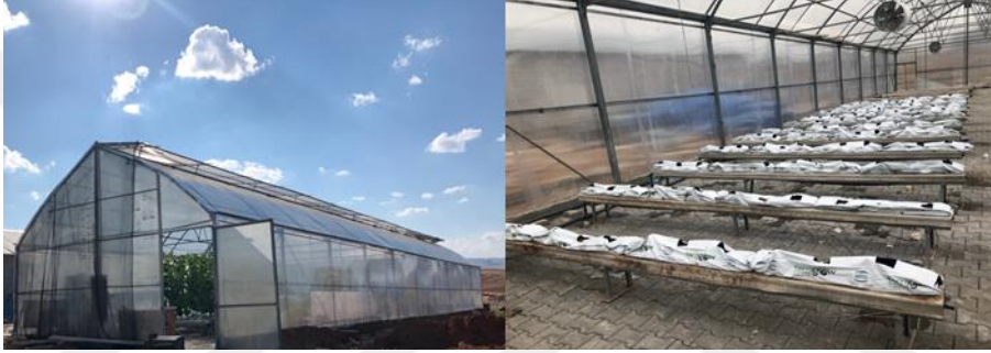
Şekil 3.1. Kırşehir Ahi Evran Üniversitesi, Ziraat Fakültesi Bahçe Bitkileri Bölümüne ait gotik tip polikarbon topraksız tarım serası
