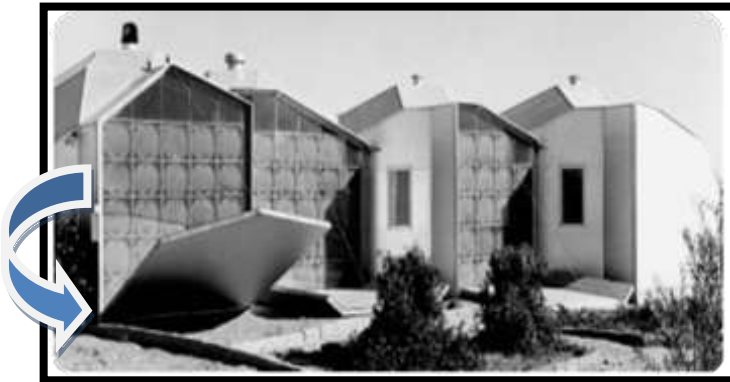
Resim 2.42. (Solar Barrel Duvarı ) Güneş ışınlarının emilmesi için edilmektedir (Arzu ve Aslıhan ,tarihsiz ).
