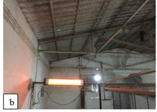
Şekil 3.5. Kümelerde katı yakıtlı (a) ve infrared (b) ısıtma sistemi
