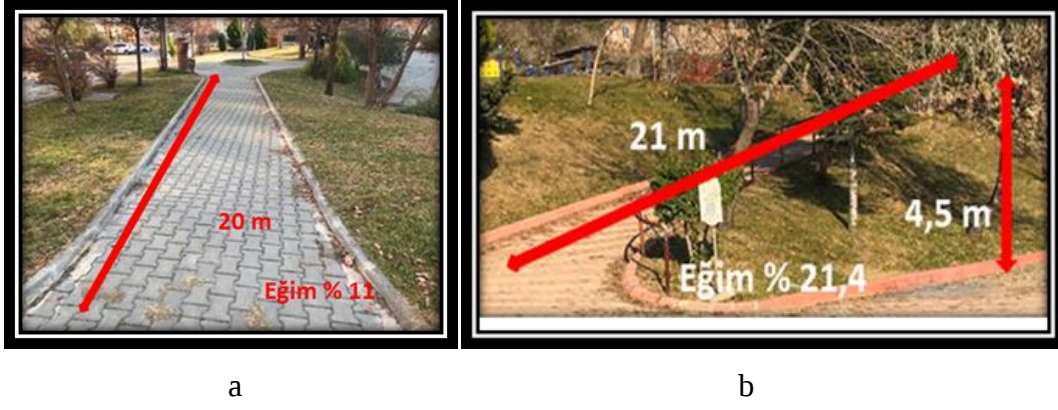
Şekil 4.12 Kent Konseyi Parkı yol eğimi (a), Sevgi Engelliler Parkı yol eğimi (b)
