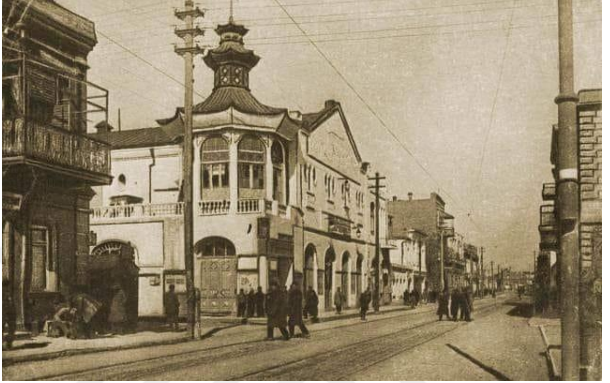
Mikado Japon Tiyatro Binası
