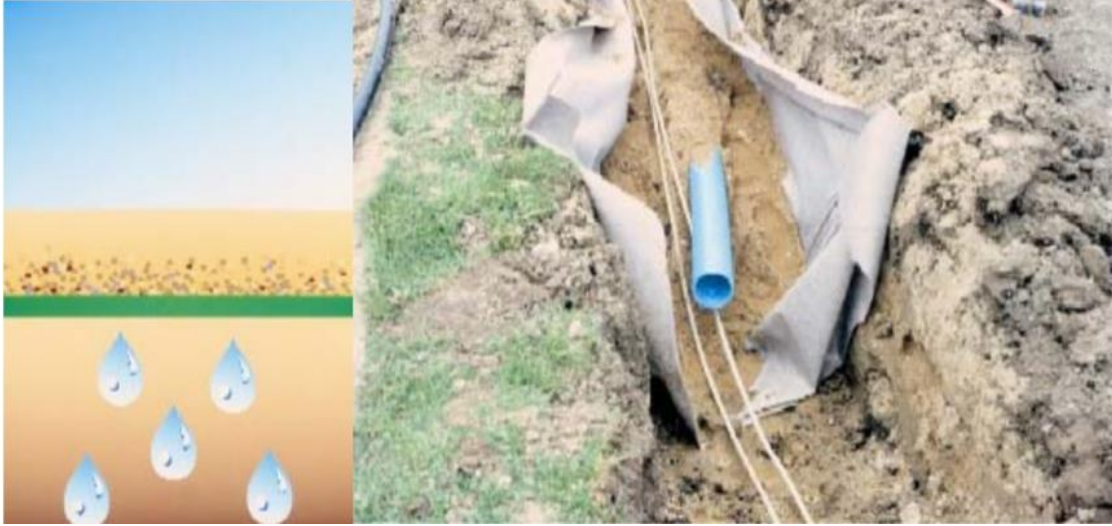
Şekil 2.5 : Geotekstilin filtrasyon amacıyla kullanımı (Koerner, 2016).
