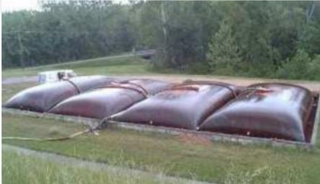
Şekil 2.7 : Geotekstil tüplerin dolum aşaması (Şengül, 2016).
