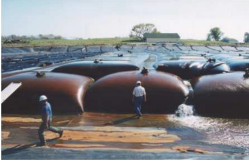
Şekil 2.8 : Susuzlaştırma aşaması (Şengül, 2016).
