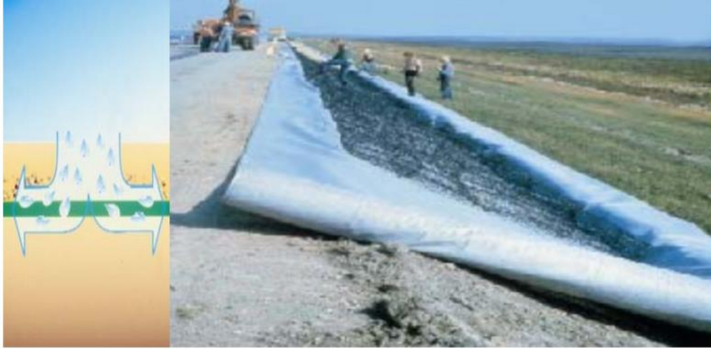
Şekil 2.4 : Geotekstilin drenaj amacıyla kullanımı (Koerner, 2016).
