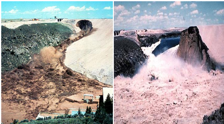
Őekil 1.2. Teton Barajı gzevdesinde oluŐan borulanma sonucu barajın yıkılması (Peker, 2015)
