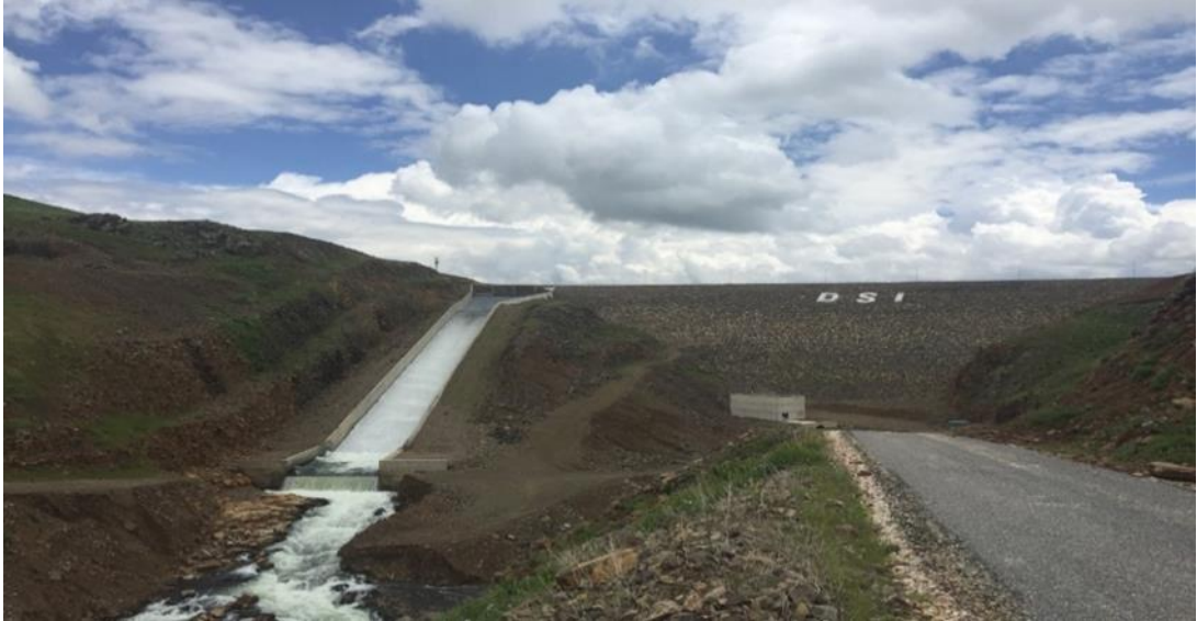
Şekil 2.2. Morgedik Barajı mansaptan görünüm (DSİ 2016)
