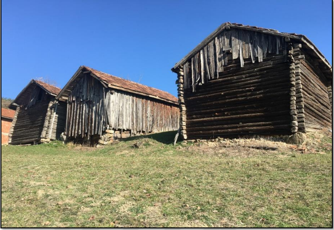
Fotoğraf 50. Karaboğaz geçme yöntemi ile yapılmış ahşap yığma samanlıklar.
