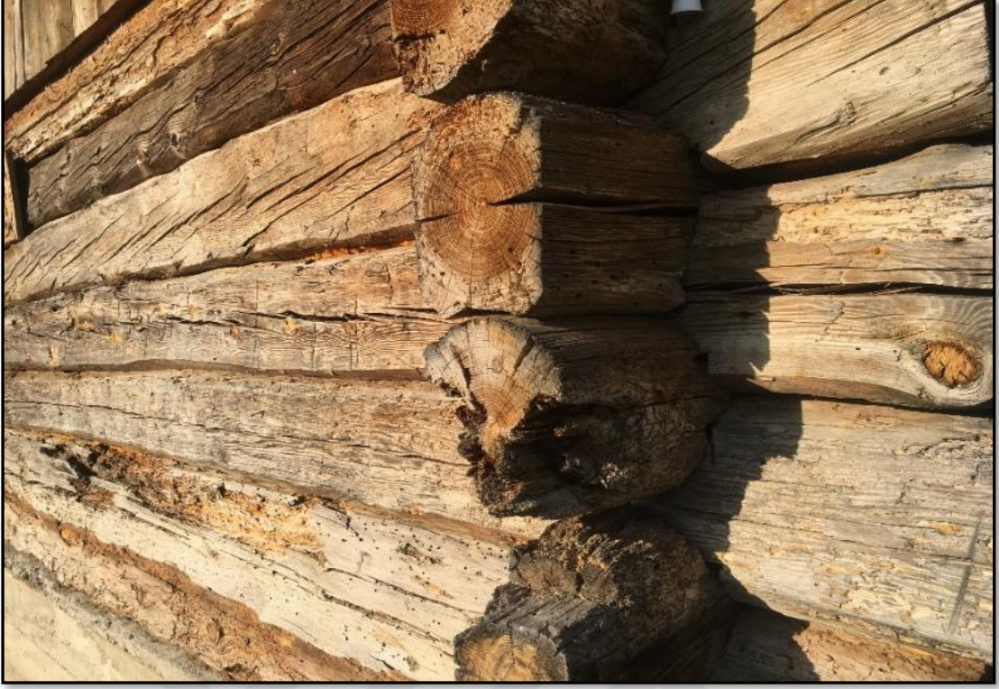
Fotoğraf 23. Araştırma sahasında karaboğaz geçme yöntemi ile yapılmış ambar duvarı.
