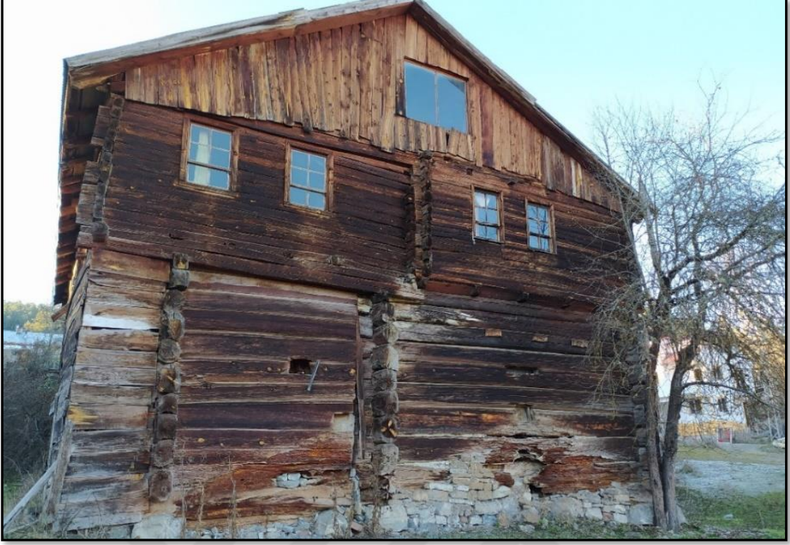
Fotoğraf 24. Oturma katı kurtboğaz, ahır katı karaboğaz geçme olarak inşa edilmiş geleneksel mesken, Gümürtler köyü.
