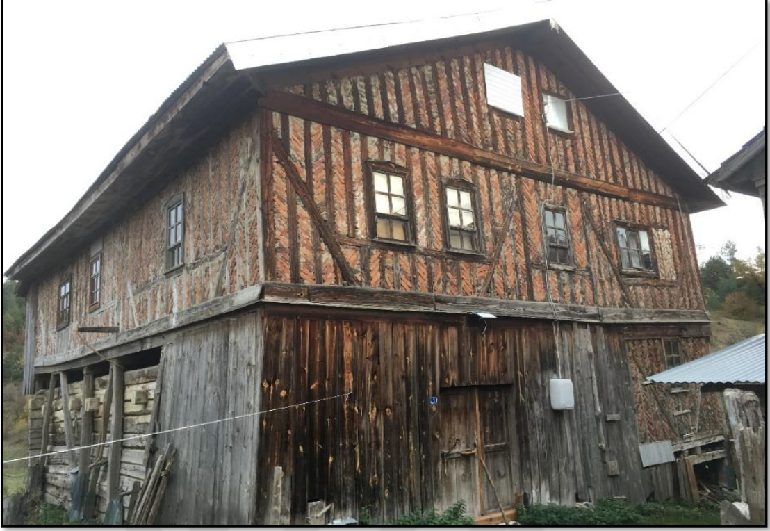
Fotoğraf 25. Ahşap çatma tekniği ile inşa edilmiş geleneksel mesken örneği, Sabuncular Köyü
