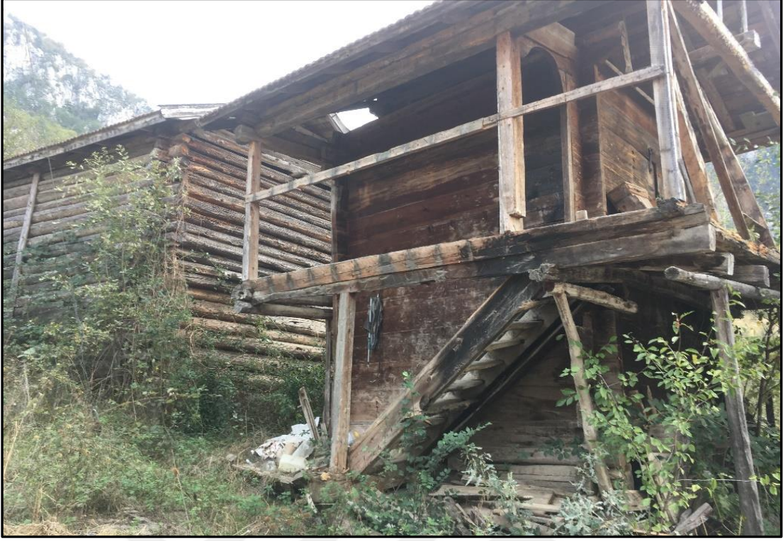
Fotoğraf 47. Ambarların alt kısmında yere çakılan dikmeler ve üst kata çıkmak için kullanılan merdiven, Nalbantoğlu Mahallesi.
