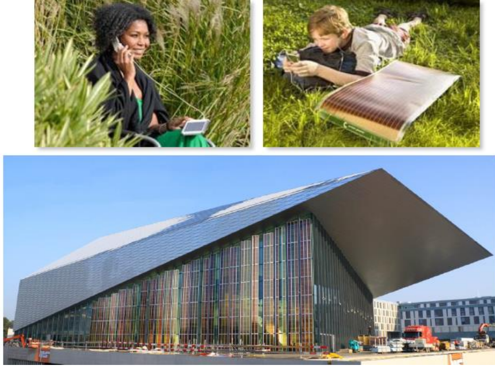
Şekil 2. BDGG'nin gerçek hayatta kullanımı (üstte) G24: mobil cihazlar için güneş enerjisi şarjı (altta) Solaronix'in İsviçre'deki EPFL'deki SwissTech Kongre Merkezi'ndeki çok renkli şeffaf fotovoltaik cephe (Wooh et al. 2015).
