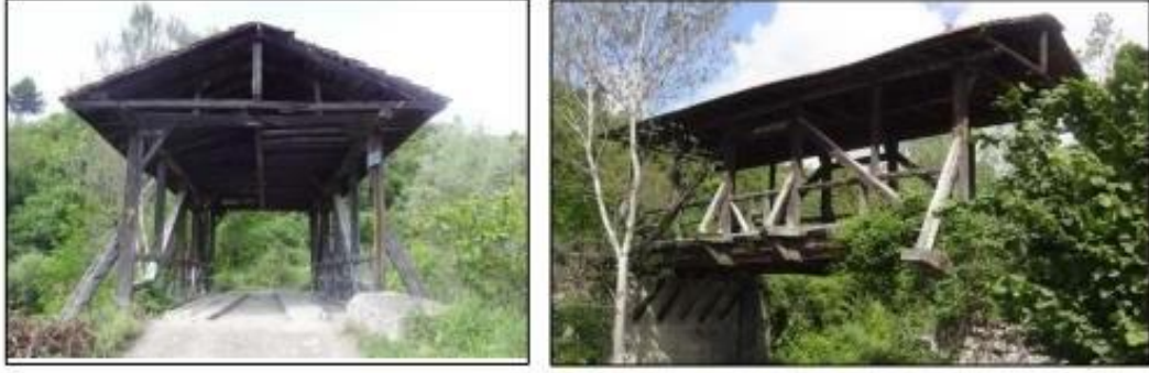
Şekil 8.15. : Kastamonu- Tarihi Dörtocak Köprüsü [69].
