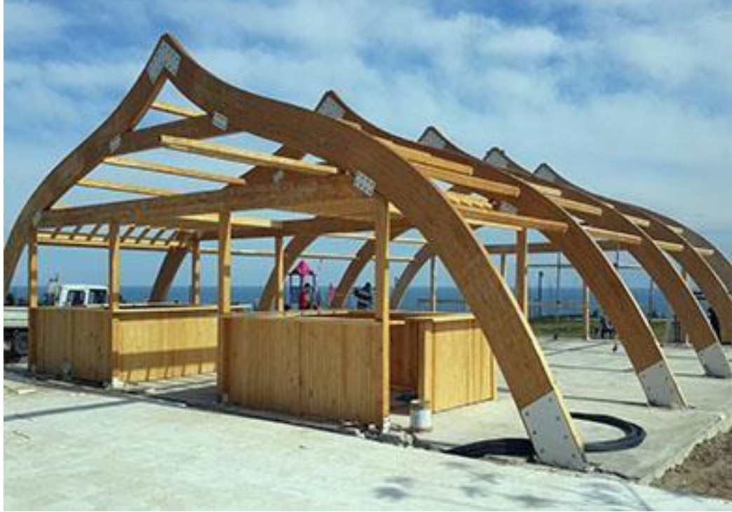
Şekil 10.8. : Ahşabın laminasyon tekniği uygulanarak kolay şekil verilebilirliği [107].
