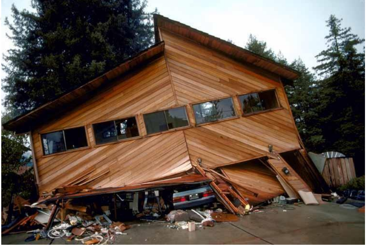
Şekil 10.5. : Deprem sonrasında A.B.D. 'de ahşap konstrüksiyon bir konut [104].
