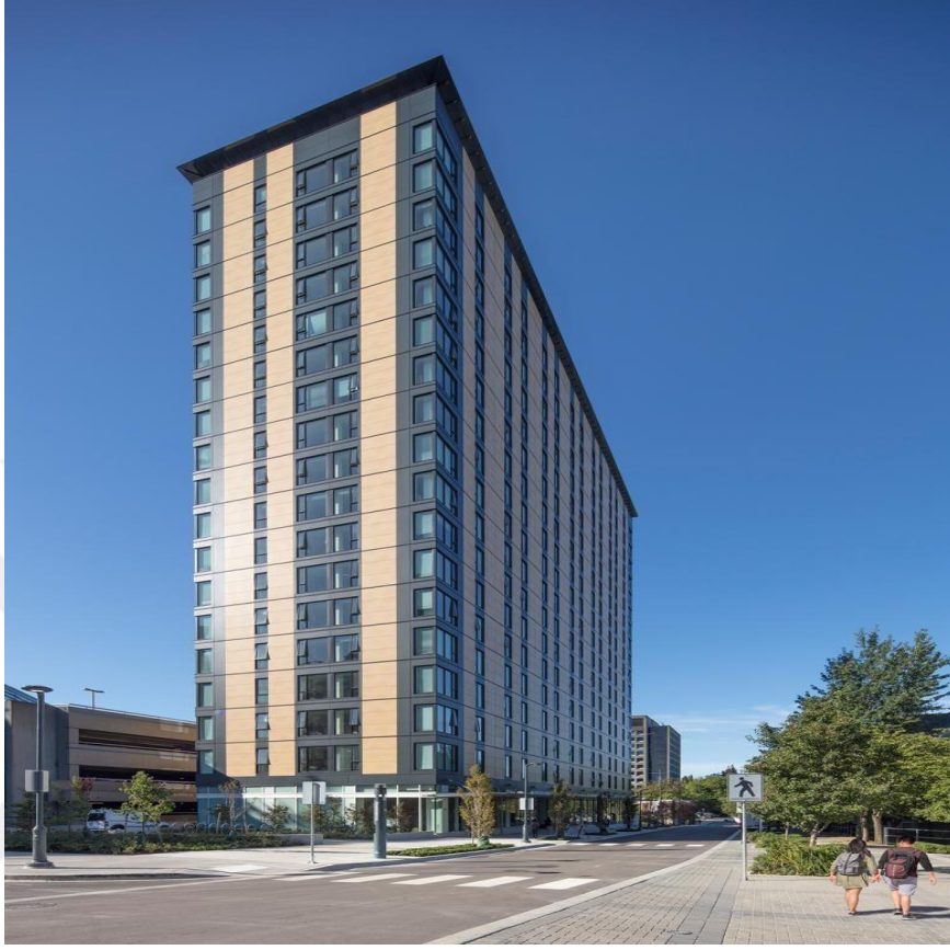
Şekil 9.18. : UBC Student Residence, Kanada [89].
