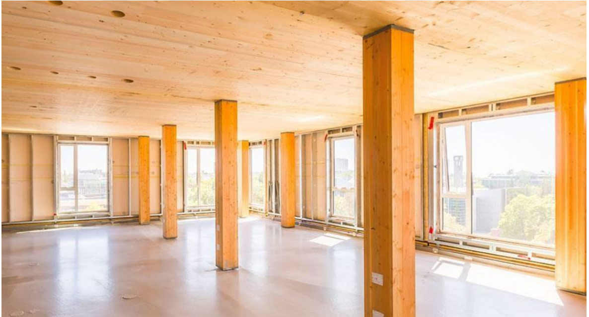
Şekil 6.8. : CLT ile yapılmış kolonlar (UBC / Kanada yurt resimleri) [49].
