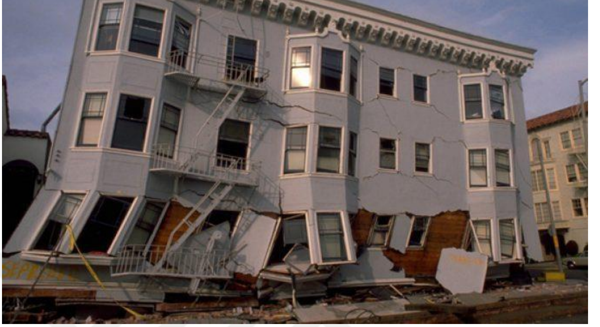
Şekil 10.4. : Hindistan'da deprem sonrasında ahşap konstrüksiyon bir konut [103].
