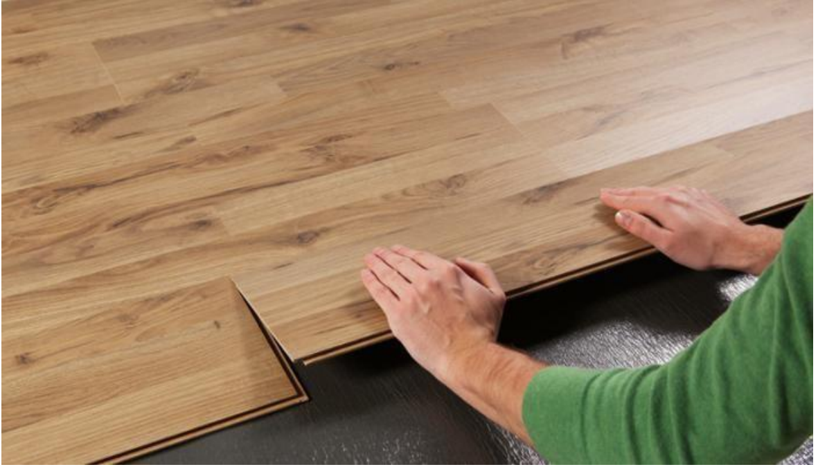
Şekil 5.5. : Ahşap parkede geçmeli lamba-zıvana birleşimi [41].
