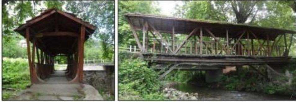
Şekil 8.13. : Kastamonu-Tarihi Yakaören Köprüsü [69].
