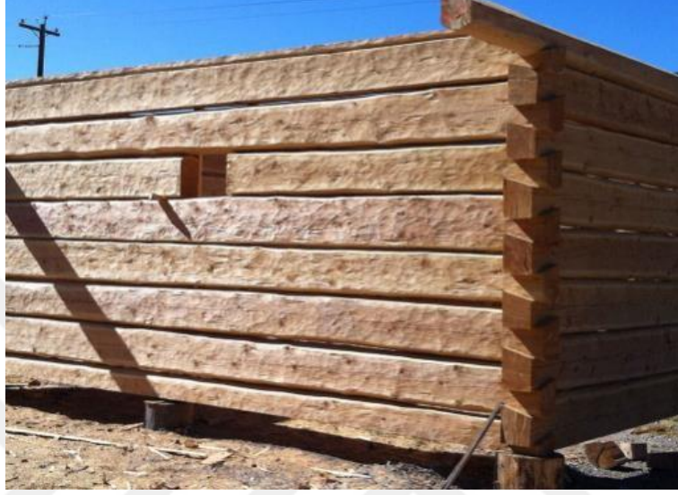
Şekil 5.8. : Dişli bağlantı ile yapılmış ahşap bir yapı [42].
