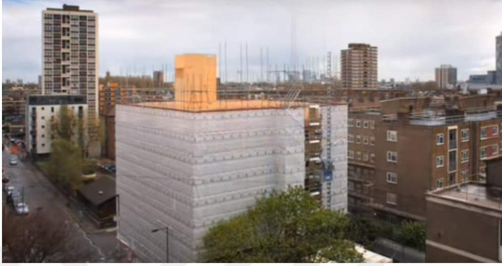
Şekil 9.9. : Murray Grove, İngiltere-projenin yapım aşamasından çekilen bir kare; taşıyıcıları ve zemini ahşaptan yapılma [81].
