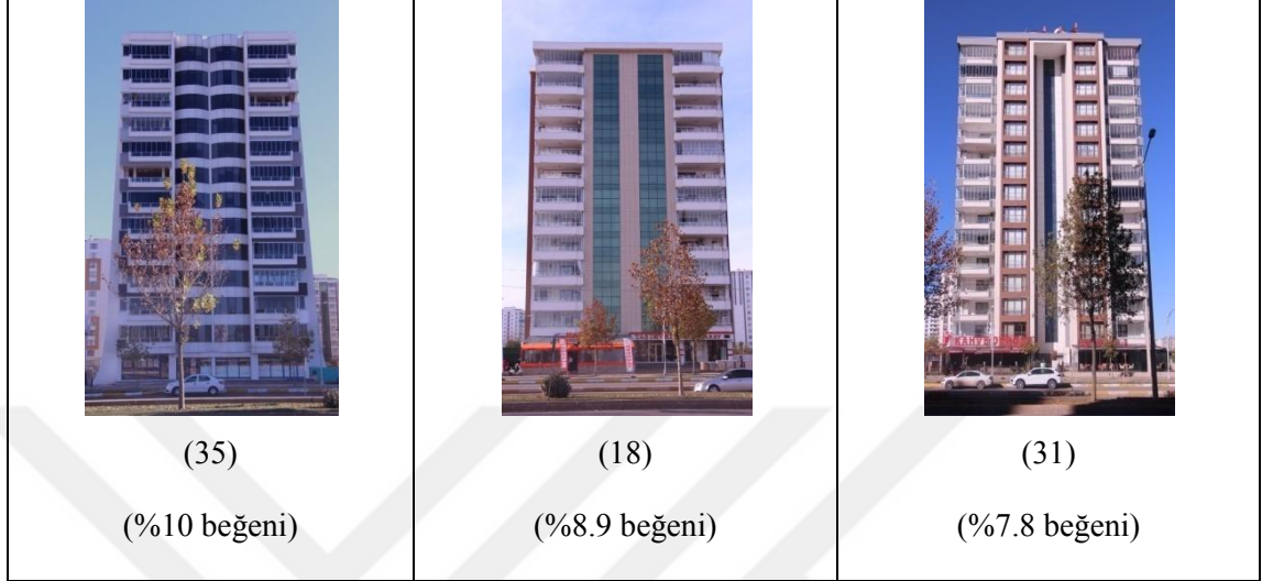
Şekil 4.24. Mimar Olamayan Katılımcı İçin İkinci Derece En Beğenilen Konutlar
