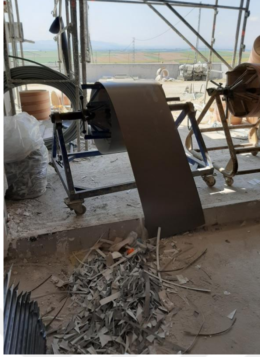
Şekil 6.6 : Metal kenetli çatı kaplama uygulamasında kullanılan metal rulo malzeme.
