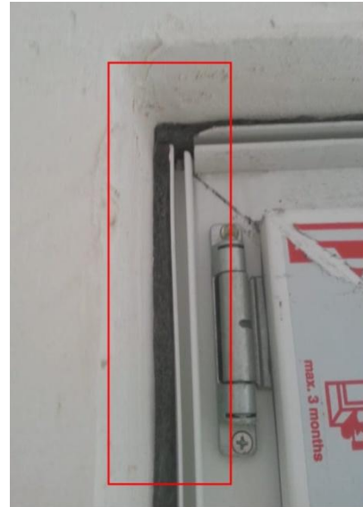
Şekil 3.12 : Tema İstanbul Bahçe döşemeden kesilen polietilen şiltelerin pencere kenarlarında kullanımı.
