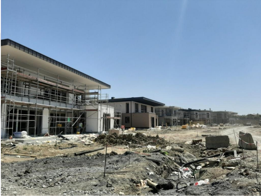
Şekil 6.1: Şantiyeden bir görünüm.
