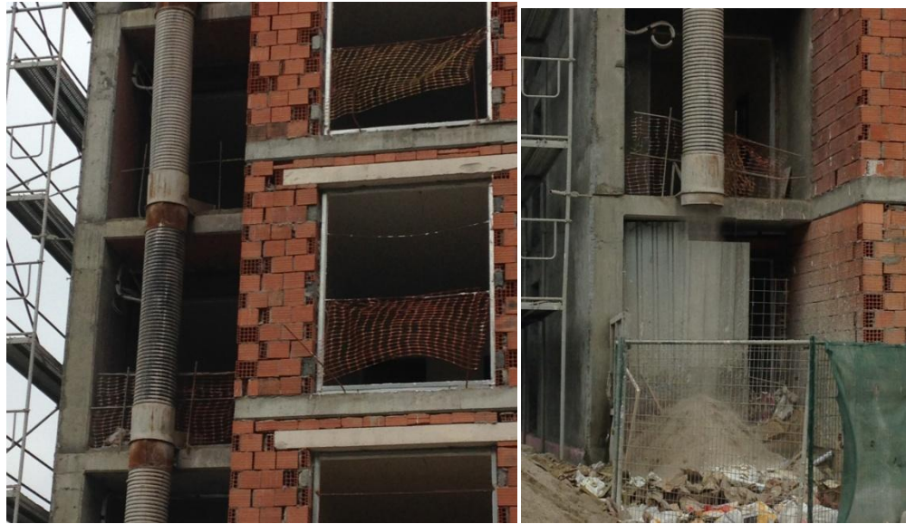
Şekil 3.10 : Cephelerde atık borusu uygulaması detay görünümü.
