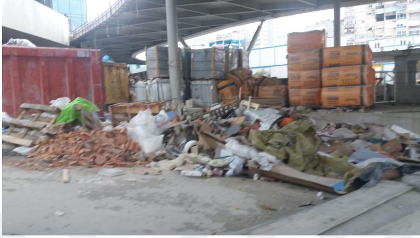
Şekil 3.5 : Şantiyede yapım sırasında oluşan atıklar.
