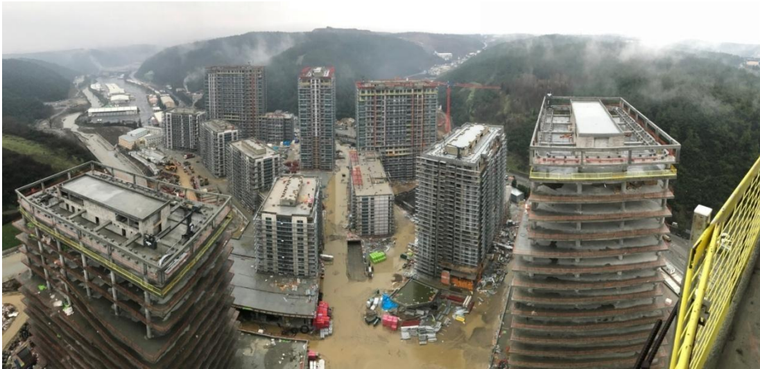
Şekil 3.1 : Şantiyeden genel bir görünüm.
