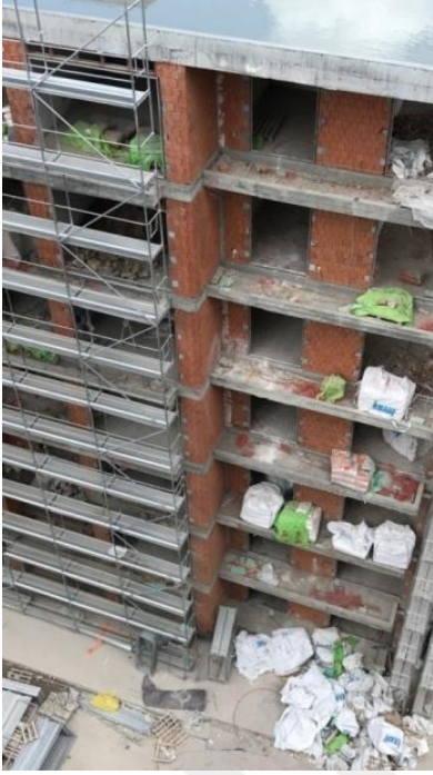
(a) Atık borusu olmayan blok uygulaması (b) Atık borusu kullanılan uygulama
