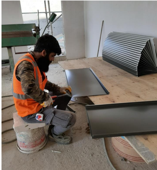
Şekil 6.9 : Metal levhaların köşelerinin bükülmesi.
