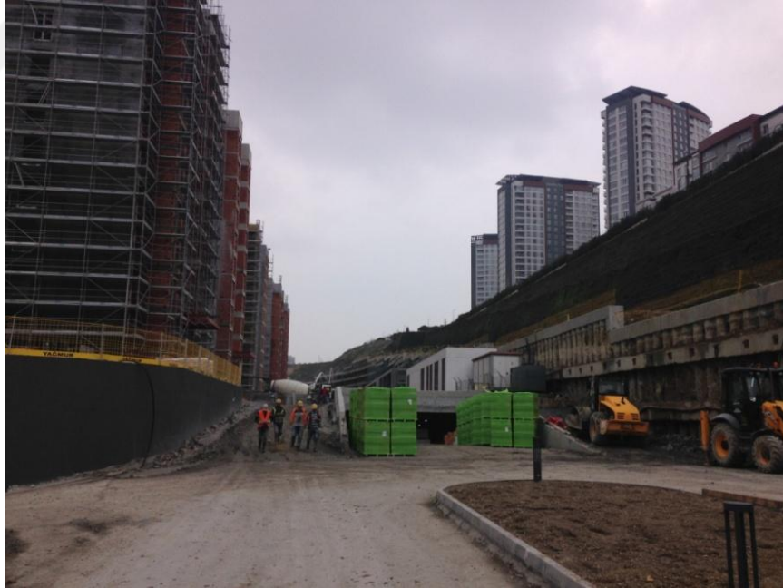
Şekil 3.8 : Şantiyeden genel bir görünüm.
