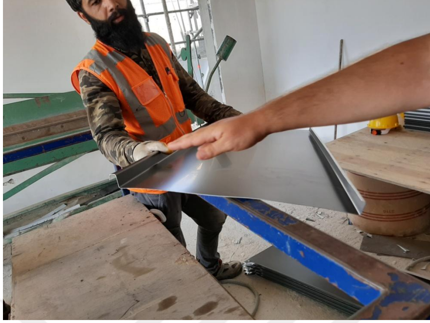
Şekil 6.8 : Şekillendirme sonucu oluşan kenetli levha.
