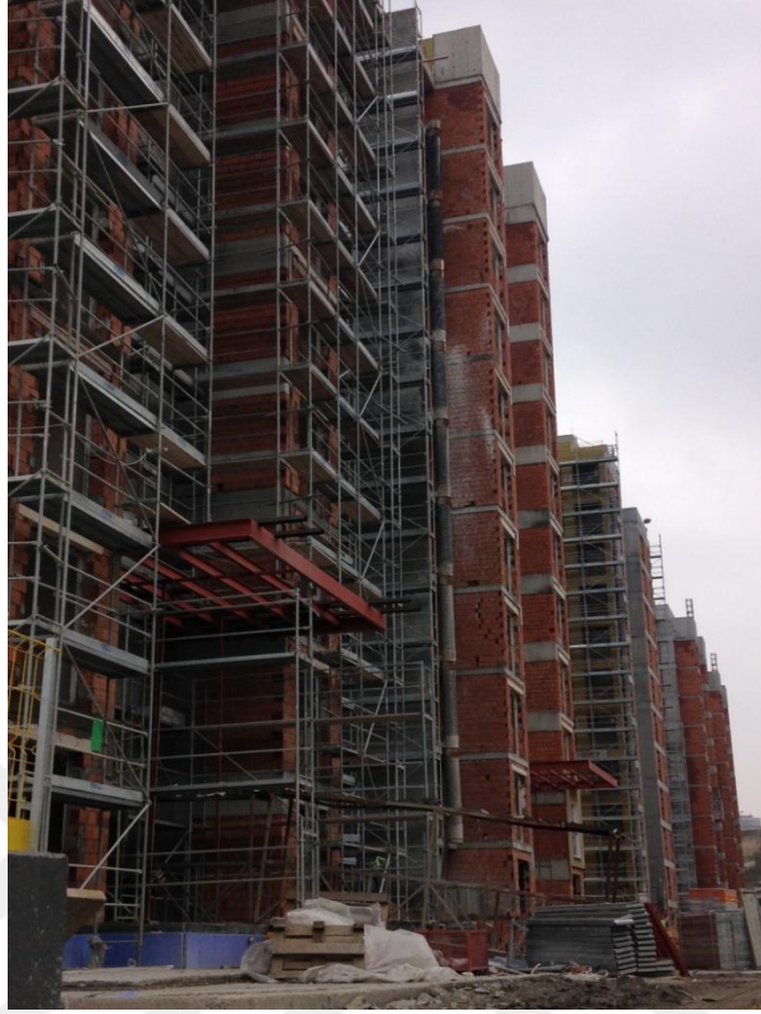
Şekil 3.9 : Cephelerde atık borusu uygulaması.
