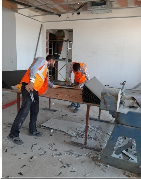
Şekil 6.10 : Metal levhaların köşelerinin kesilmesi.
