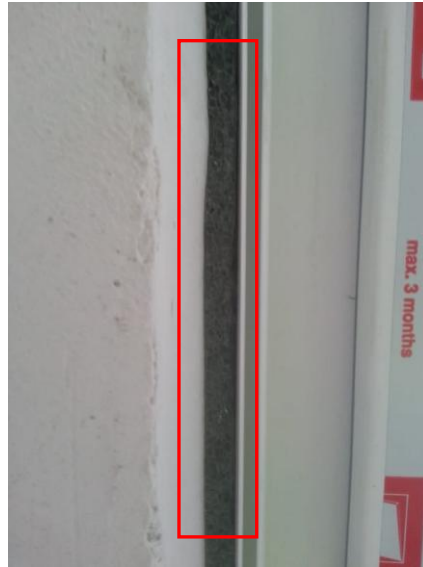
Şekil 3.12 : Tema İstanbul Bahçe döşemeden kesilen polietilen şiltelerin pencere kenarlarında kullanımı.
