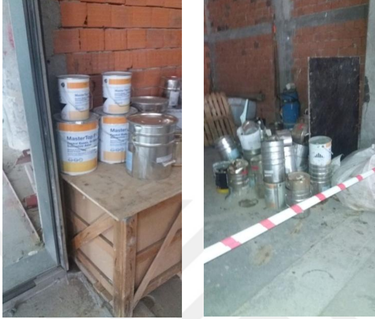
Şekil 3.7 : Yalıtım malzemesi kutuları-zararlı atıklar.
