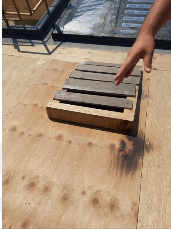
Şekil 6.3 : Kiremit altı kapma uygulaması sırasında atıkların yeniden kullanımı.
