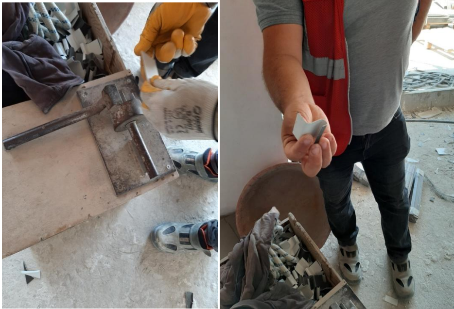
Şekil 6.11 : Metal kenetlerin biçimlendirilmesi.
