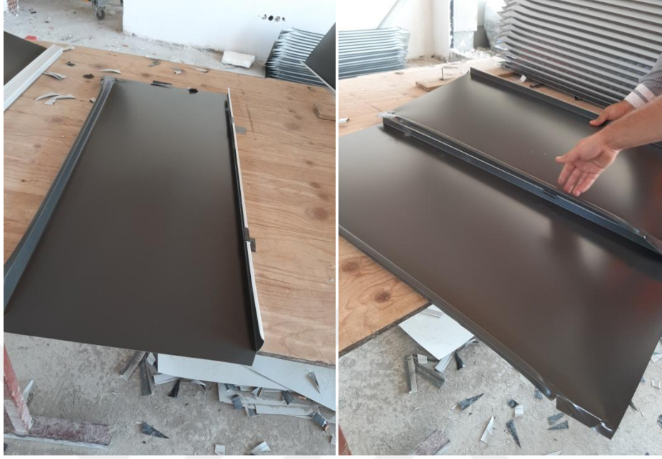
Şekil 6.12 : İki levhanın geçme yapılarak mekanik birleşimi.
