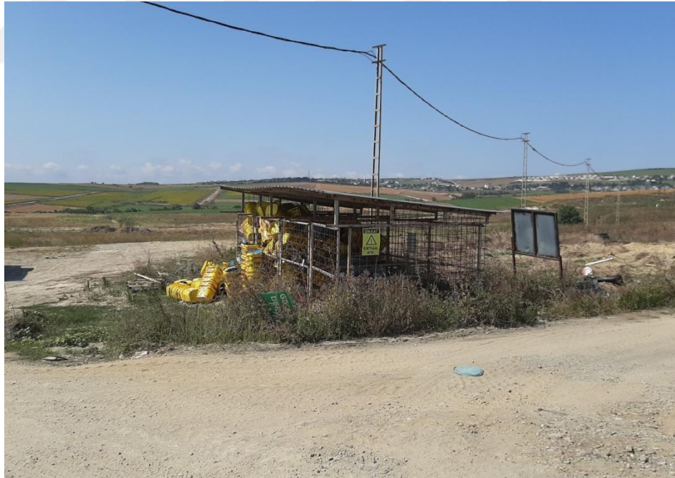
Şekil 3.13: Şantiyede üretilen zararlı atıkların geçici depolama şekli.
