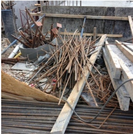
Şekil 3.14 : Boyutlandırma sonucu oluşan çelik donatı atığı.
