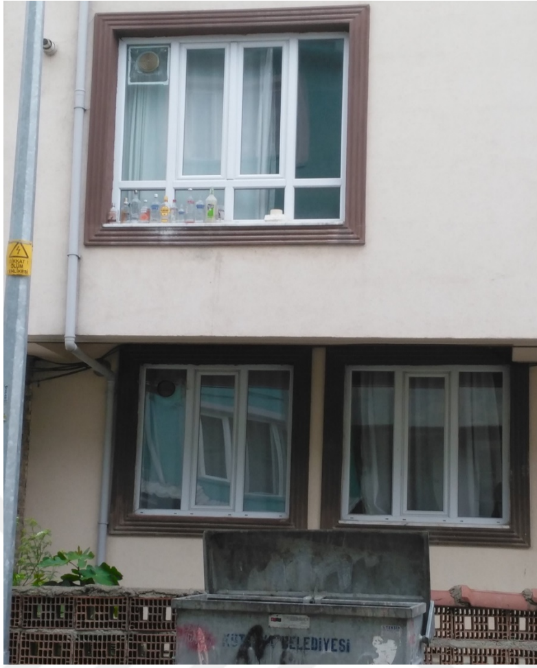
ŞEKİL 4. Kütahya M. Mahallesinden Bir Ev
