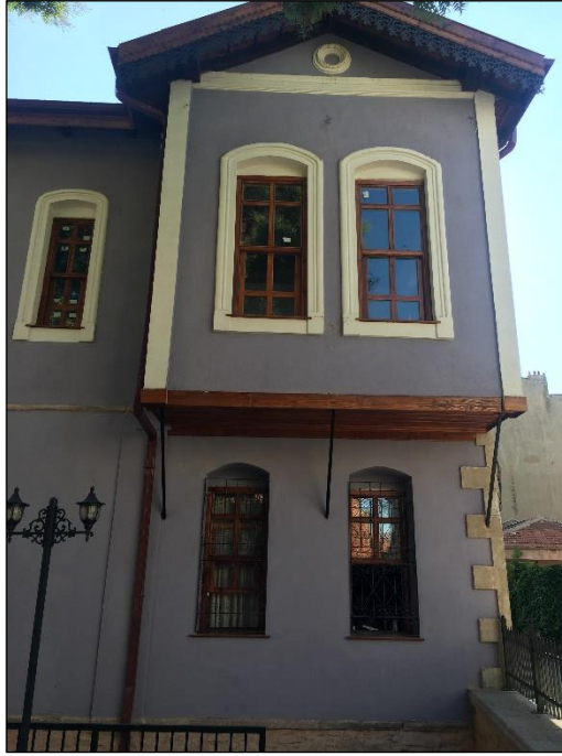
Şekil 5.49 Doğu cephesindeki cumbanın görünüşü (Yağcı, 2020).
