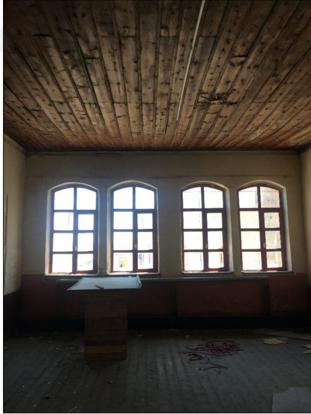
Şekil 5.82 Güneydoğu cephesine bakan diğer derslik mekânı (Yağcı, 2020).
