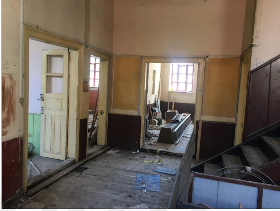
Şekil 5.71 Zemin kat giriş holü (Yağcı, 2020).
