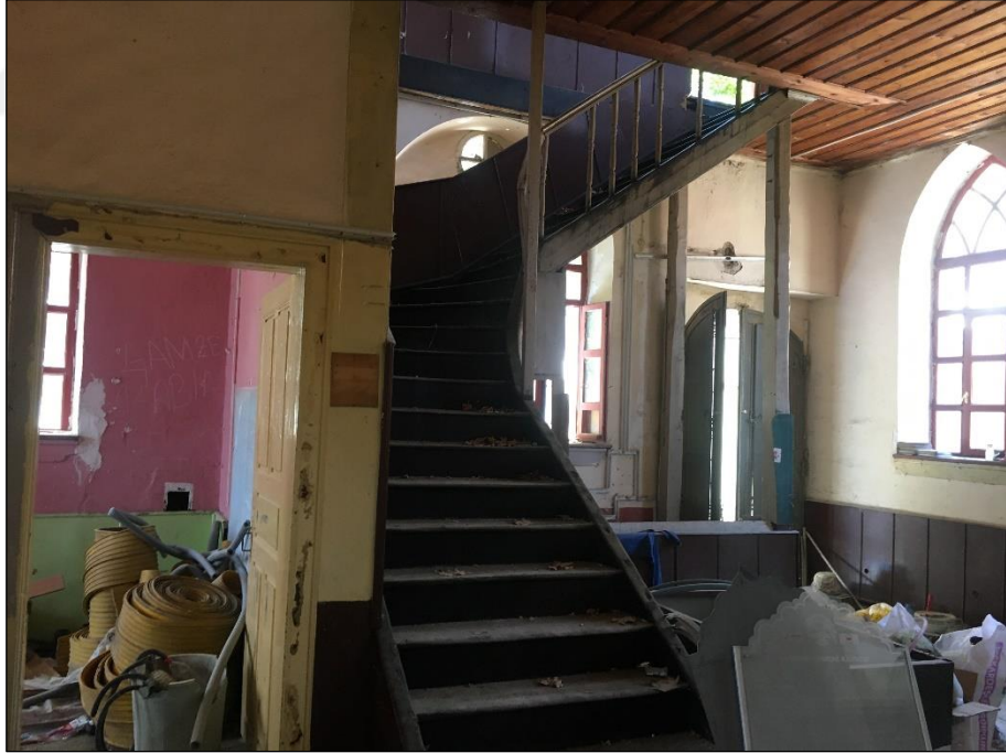
Şekil 5.72 Zemin kat merdiveni (Yağcı, 2020).
