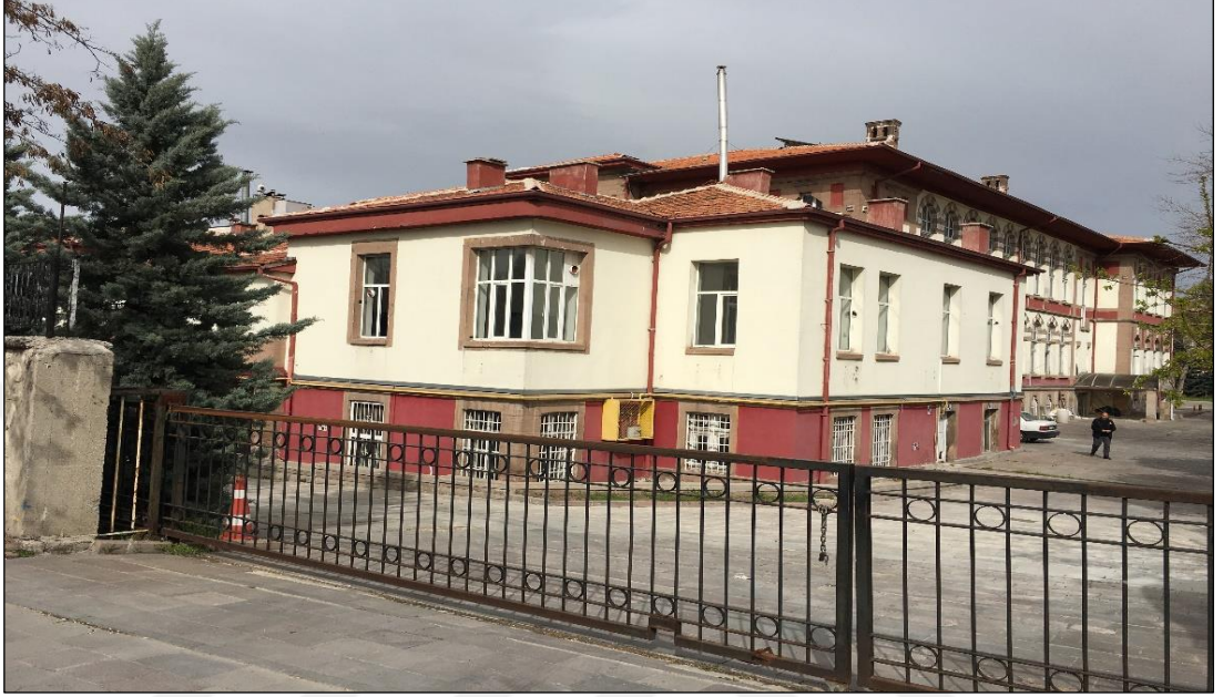
Şekil 3.51 Binanın batı cephesine yapılan eklenti (Yağcı, 2020).
