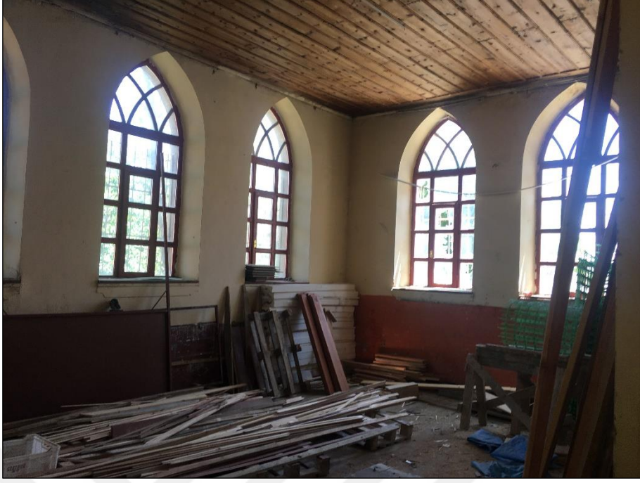
Şekil 5.73 Kuzeydoğu cephesine bakan derslik mekânı (Yağcı, 2020).
