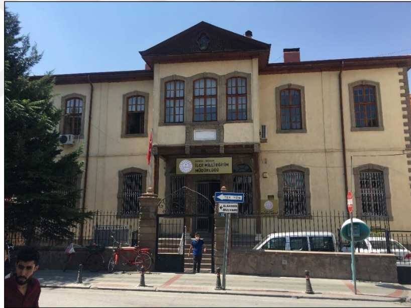
Şekil 5.101 Konya Fransız Erkek Mektebi güneydoğu cephesi (Yağcı, 2020).
