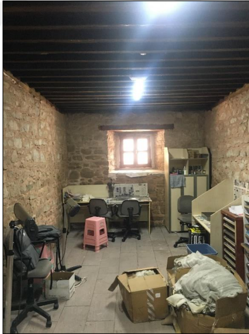
Şekil 5.24 Bodrum kat tavanı ahşap kirişlemeler (Yağcı, 2020).
