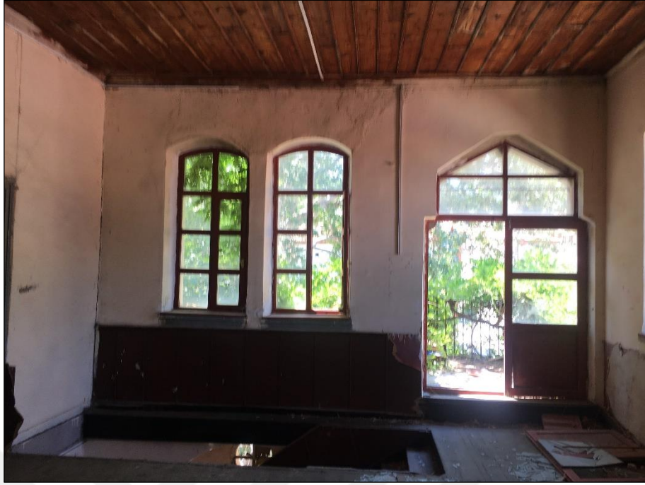
Şekil 5.79 Birinci kattan balkona açılan kapı (Yağcı, 2020).
