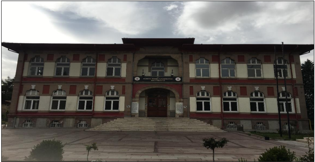
Şekil 3.58 Darülmuallimat doğu cephesi (Yağcı, 2020).
