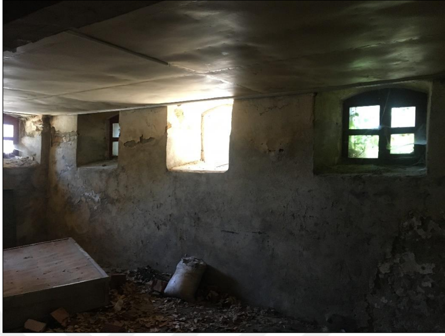
Şekil 5.92 Bodrum kat odunluk mekanının tavan görünüşü (Yağcı, 2020).
