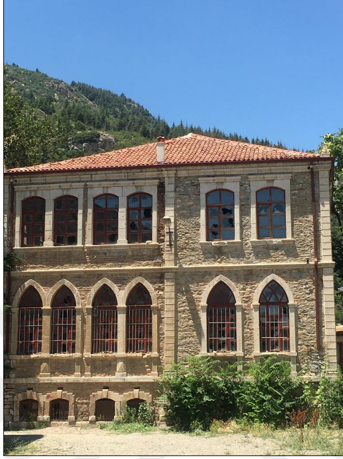
Şekil 5.89 Akşehir Ermeni Mektebi güneydoğu cephesi (Yağcı, 2020).
