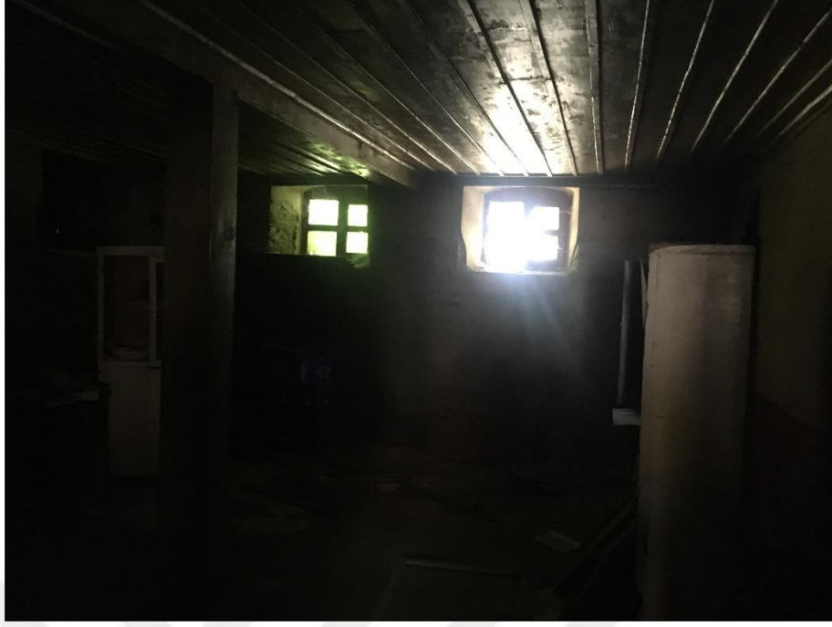
Şekil 5.94 Bodrum kat arşiv mekânı tavan görünüşü (Yağcı, 2020).
