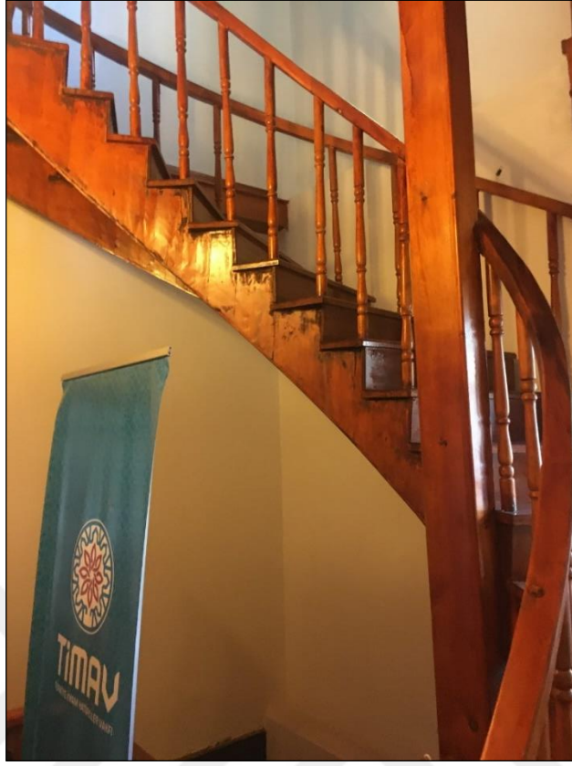
Şekil 5.32 Zemin katın güneybatısındaki döner merdiven (Yağcı, 2020).
