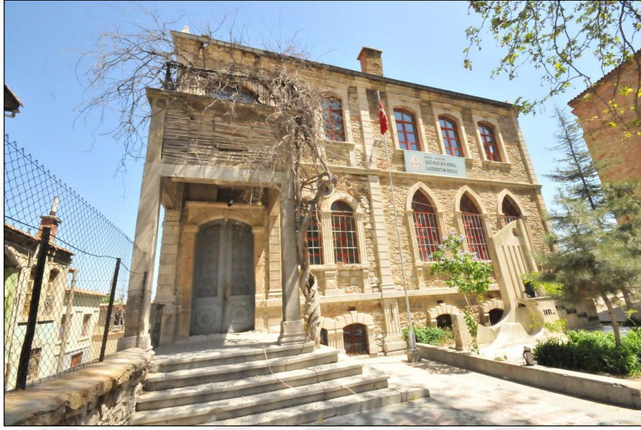
Şekil 5.85 Akşehir Ermeni Mektebi giriş cephesi (Yağcı, 2020).
