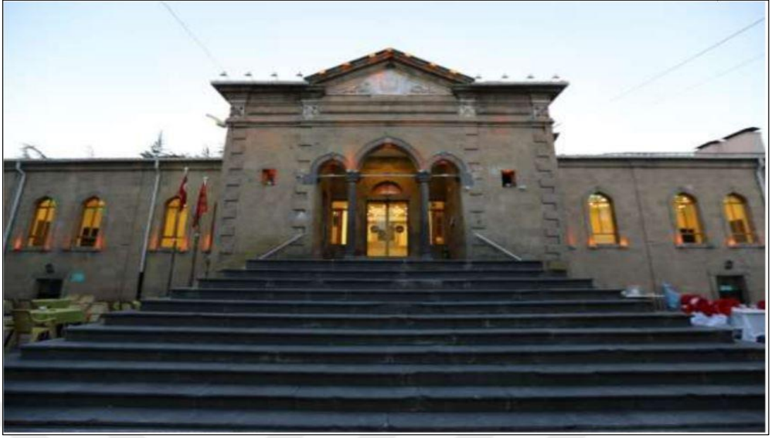
Şekil 3.35 Niğde Darülmuallimini giriş cephesi (Toptaş, 2017).
