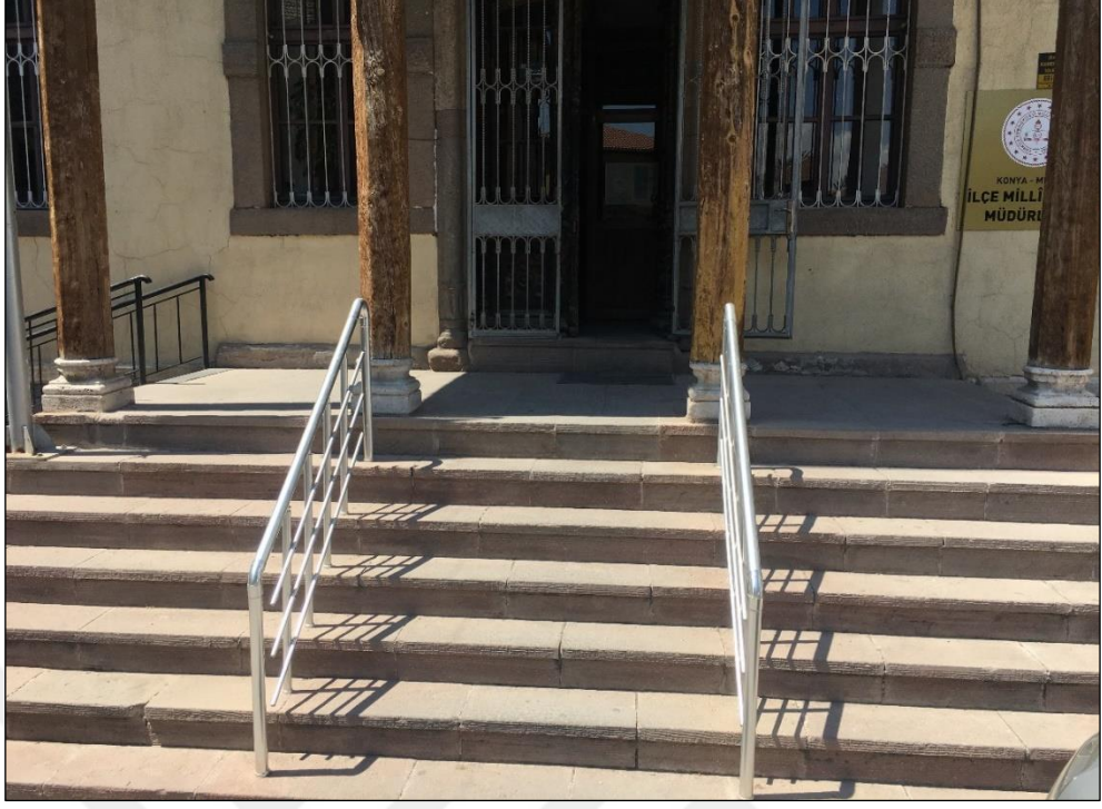
Şekil 5.112 Fransız Erkek Mektebi giriş merdiveni (Yağcı, 2020).
