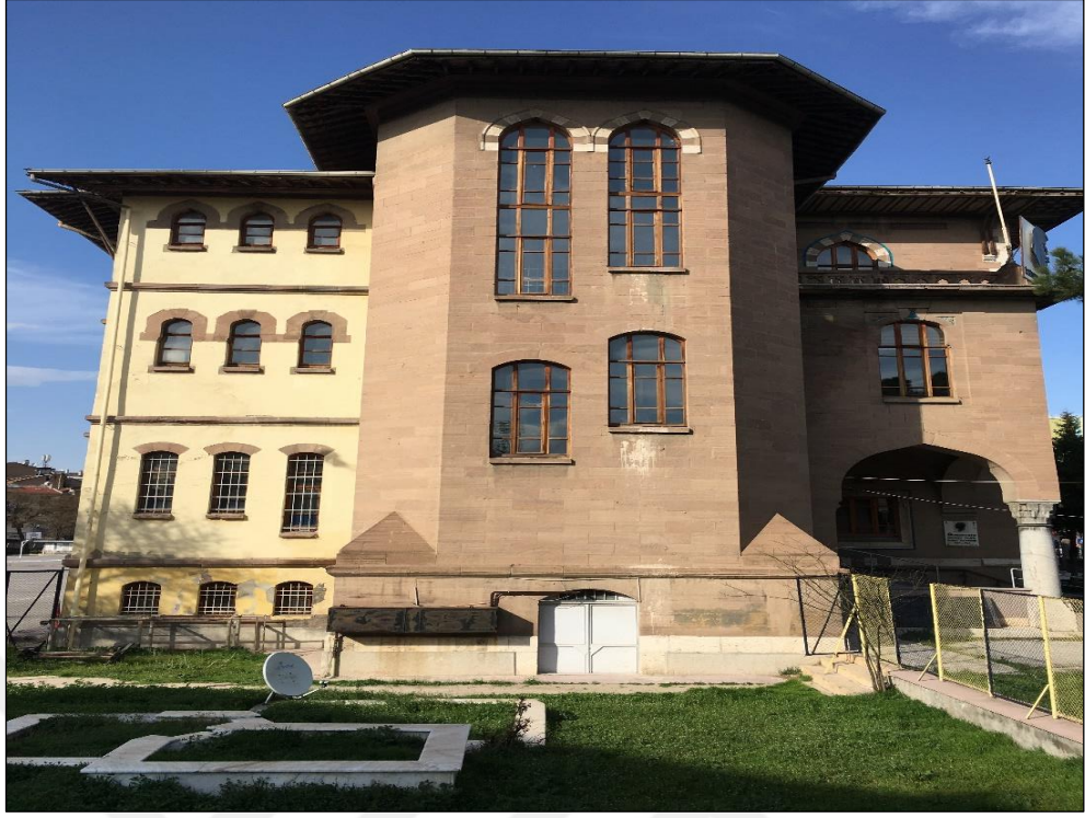
Şekil 3.46 Konya Darülmuallimini sol yan cephe (Yağcı, 2020).
