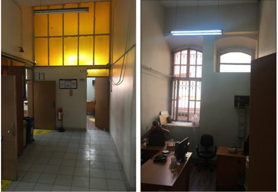
Şekil 5.117 Fransız Erkek Mektebi santral odasının görünüşü (Yağcı, 2020).
