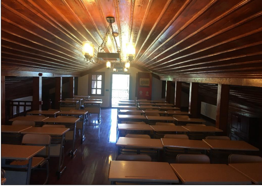
Şekil 5.42 Çatı Katı ahşap kiriş ve kolonlar (Yağcı, 2020).
