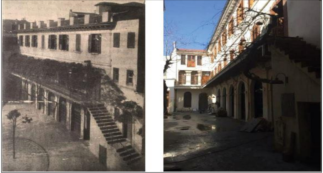
Şekil 4.51 Okulun avlusunun 1952 ve 2018 yıllarından görünümü (Kutlu, 2018).
