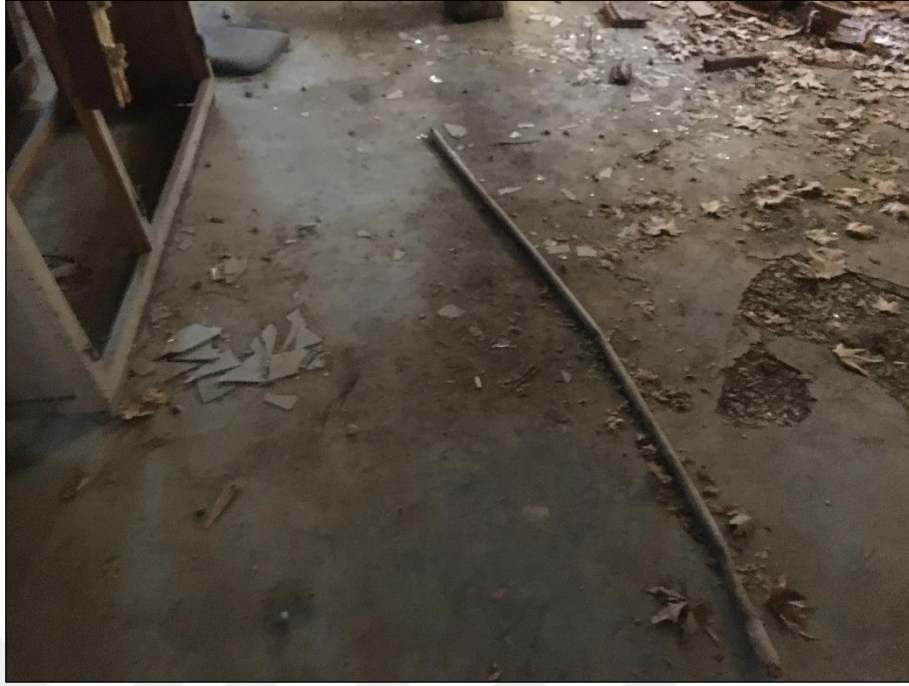
Şekil 5.96 Bodrum kat zemin kaplaması görünüşü (Yağcı, 2020).
