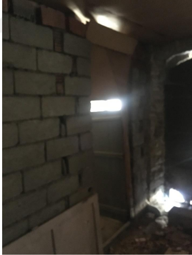
Şekil 5.95 Bodrum kat odunluk mekânı muhdes duvar (Yağcı, 2020).
