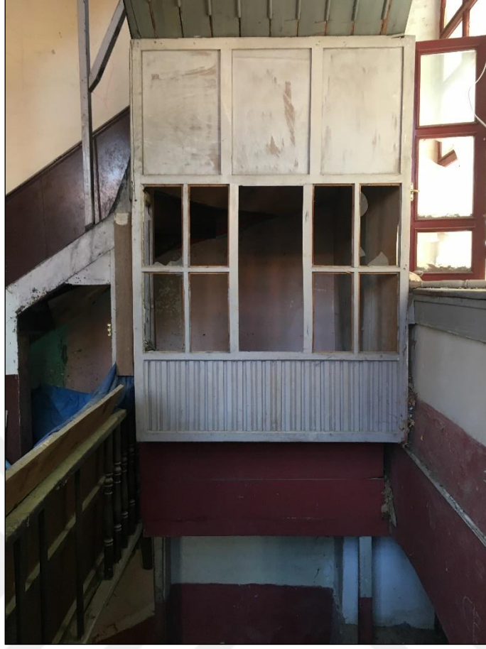
Şekil 5.77 Bodrum kat merdiveni üzerindeki danışma mekânı (Yağcı, 2020).
