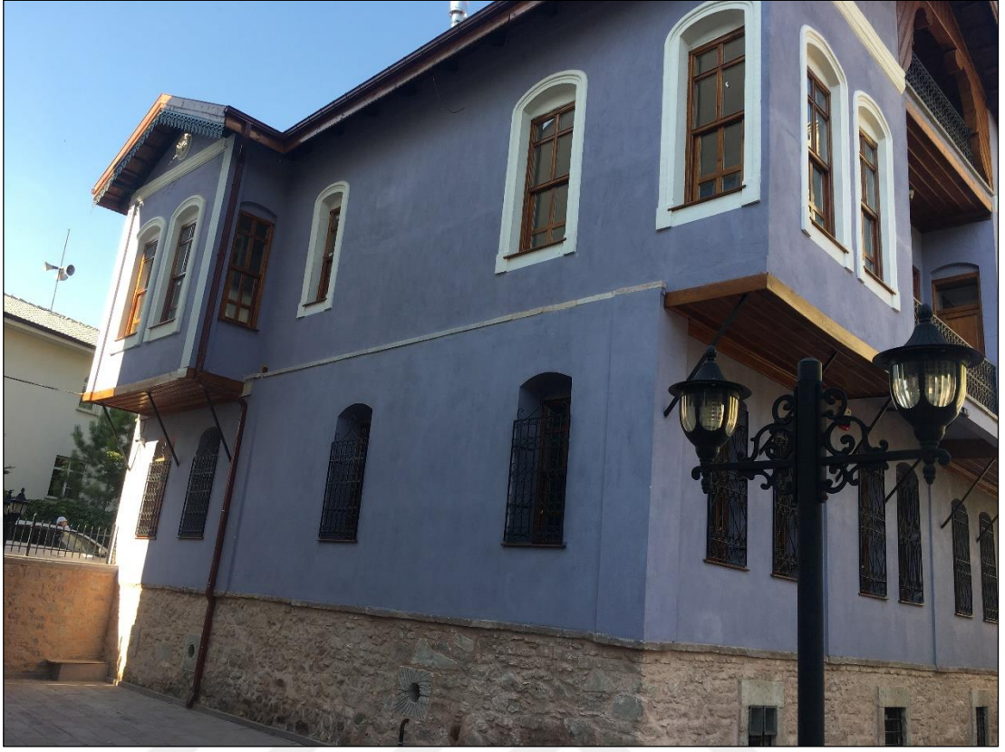
Şekil 5.51 Cenanyan Mektebi batı cephesi görünüşü (Yağcı, 2020).
