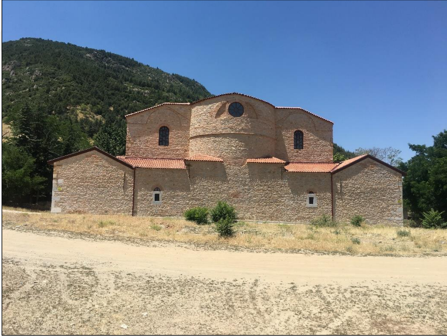
Şekil 5.61 Akşehir Ermeni Kilisesi arka cephe (Yağcı, 2020).
