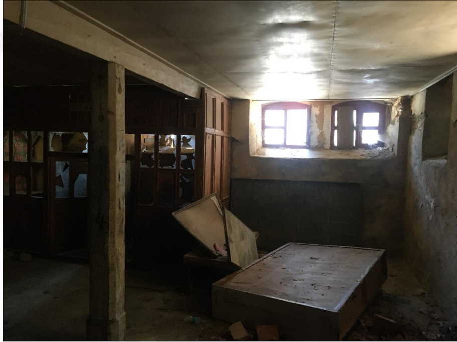
Şekil 5.93 Bodrum kat kantin mekânındaki ahşap kiriş (Yağcı, 2020).
