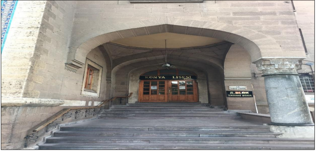
Şekil 3.38 Konya Darülmüallimini giriş saçağı ve merdiveni (Yağcı, 2020).
