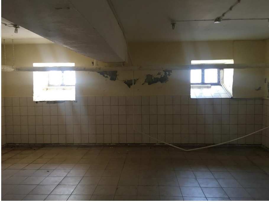
Şekil 5.108 Kuzeydoğu cephesine bakan arşiv odası (Yağcı, 2020).
