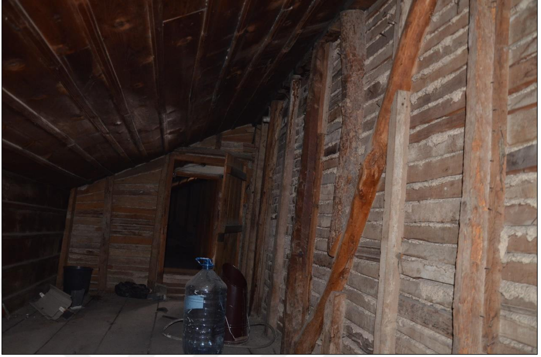
Şekil 5.53 Cenanyan Mektebi çatı katı duvar görünüşü (Yağcı, 2018).
