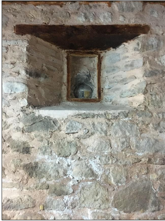
Şekil 5.22 Bodrum katın kuzeye bakan pencereleri (Yağcı, 2020).
