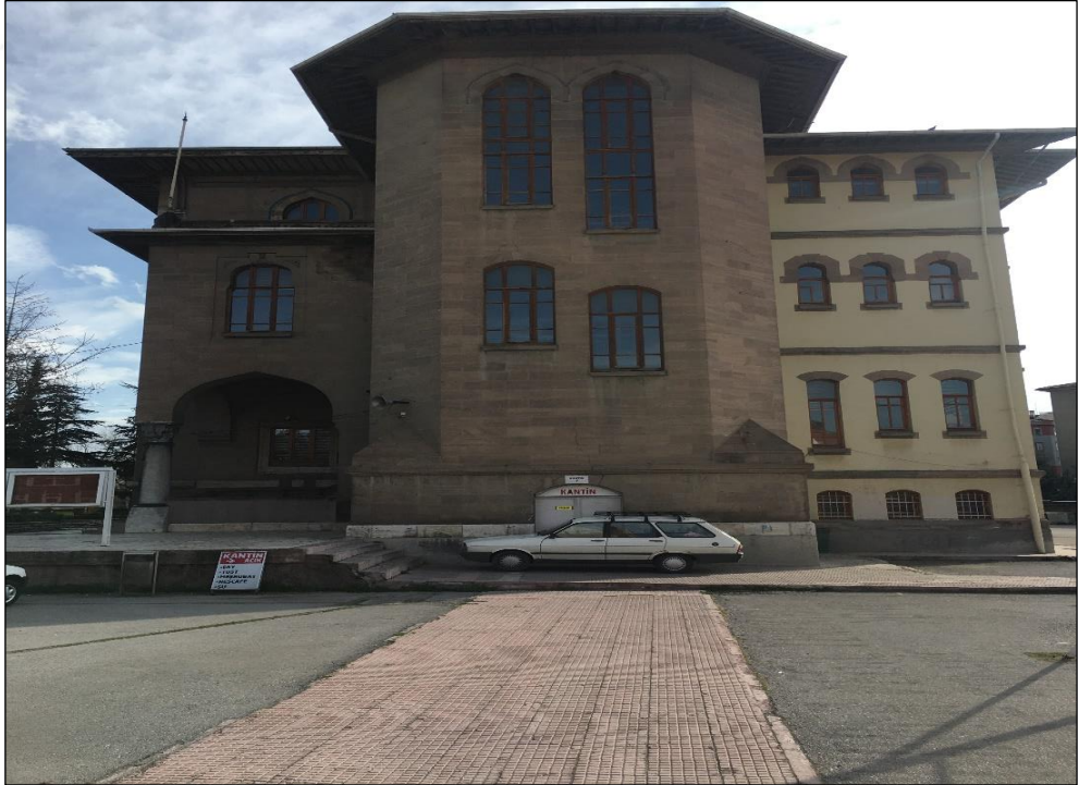
Şekil 3.47 Konya Darülmuallimini sol yan cephe (Yağcı, 2020).
