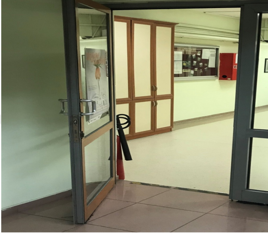
Şekil 35. Atölyede Tehlikeli İçeri Açılan Kapı
