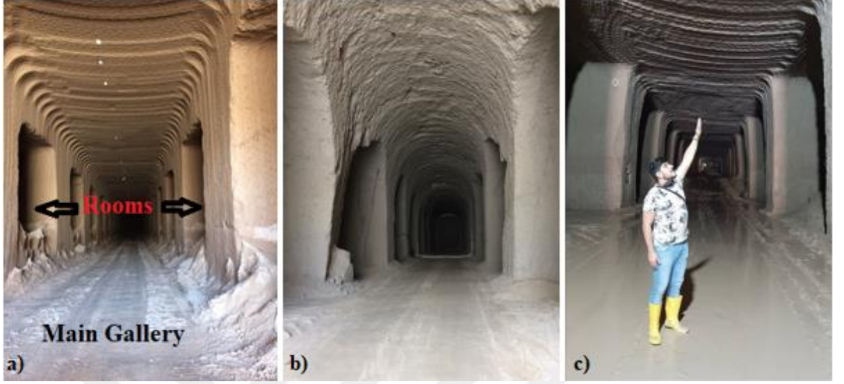
Fotoğraf 4.2. Kapadokya bölgesinde kazısı yapılan soğuk hava depolarının genel görünümü (solda), kuru ortam kazıları (orta), sulu ortam kazıları (sağda)
