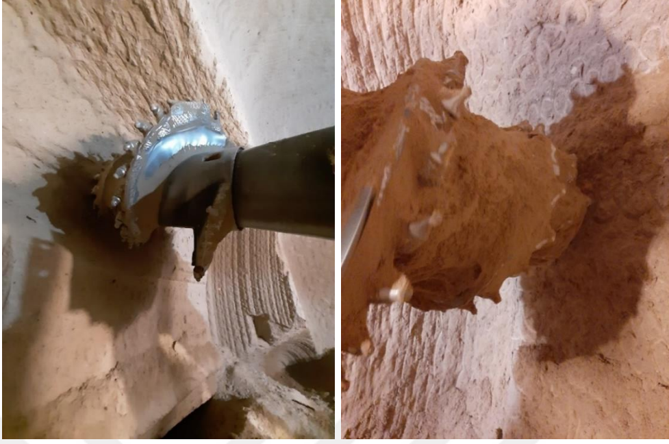
Fotoğraf 4.4 Soğuk hava deposu kazılarında kuru ortam (solda) ve sulu ortamda (sağda) yapılan kazılar sırasında kazılan malzemenin kesici kafaya ve keskilere yapışma durumu
