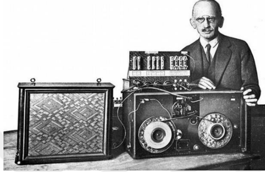
Şekil 21. Fritz Pfleumer’in Tasarlamış Olduğu İlk Manyetik Kayıt Cihazı,1932
