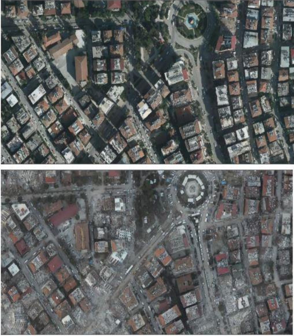
Şekil 3.14 SBB deprem sonrası değerlendirme raporu hasar genel görüntüsü
