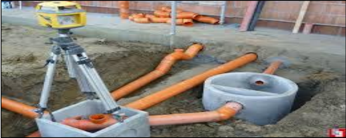
Şekil 3.12 PVC boru ile kanalizasyon bağlantısı yapılması
