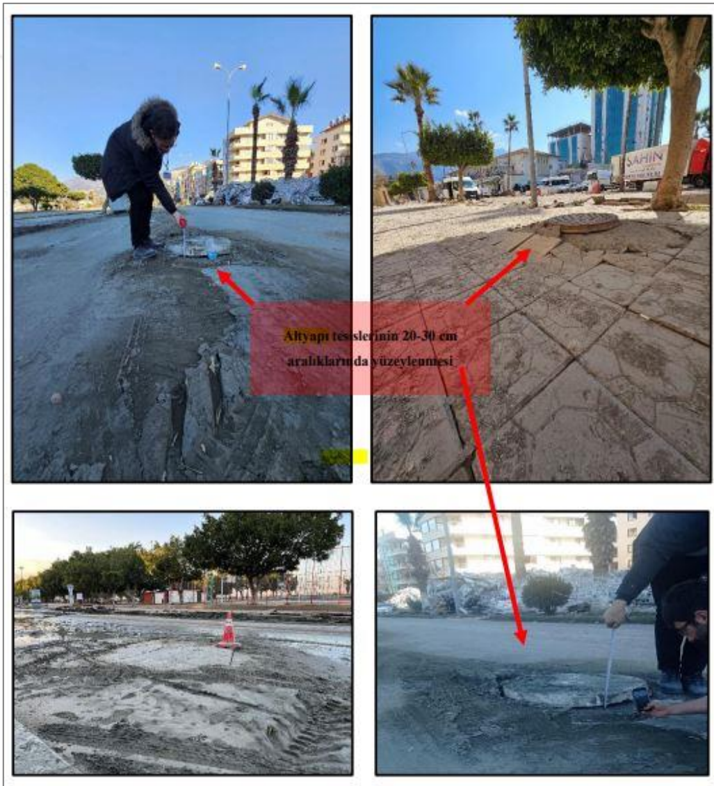
řekil 3.15 İřkenderun ilesindeki sıvılařma kaynaklı altyapı elemanlarının yzeylenmesi
