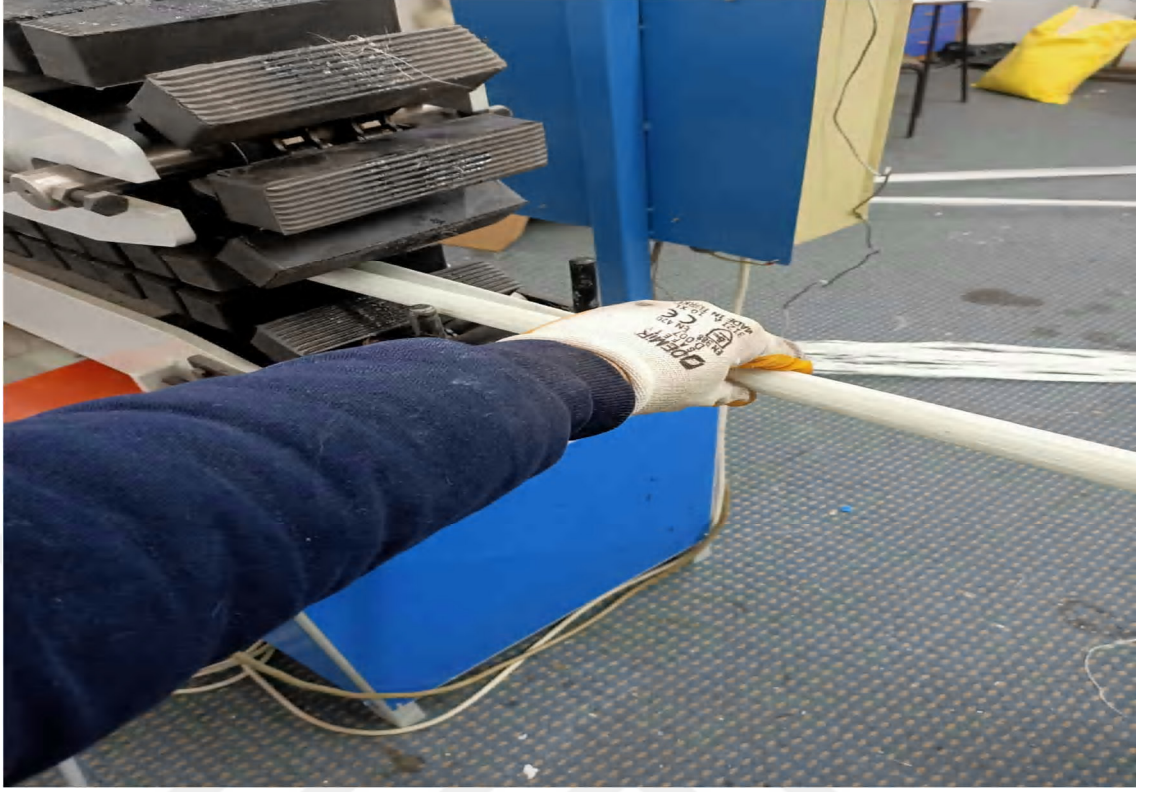
Şekil 3.1.2. Elde edilen ürünün çekme sistemiyle çekilmesi.
