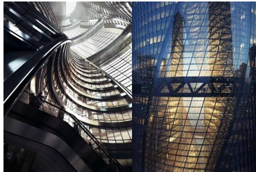
Şekil 3.87: Leeza Soho Tower atriyumu (URL-60)
