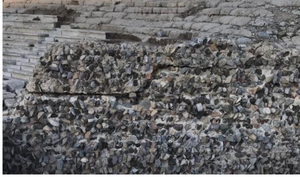
Resim 4.9. Örme Duvar, Fotoğraf, Knidos, 2021
