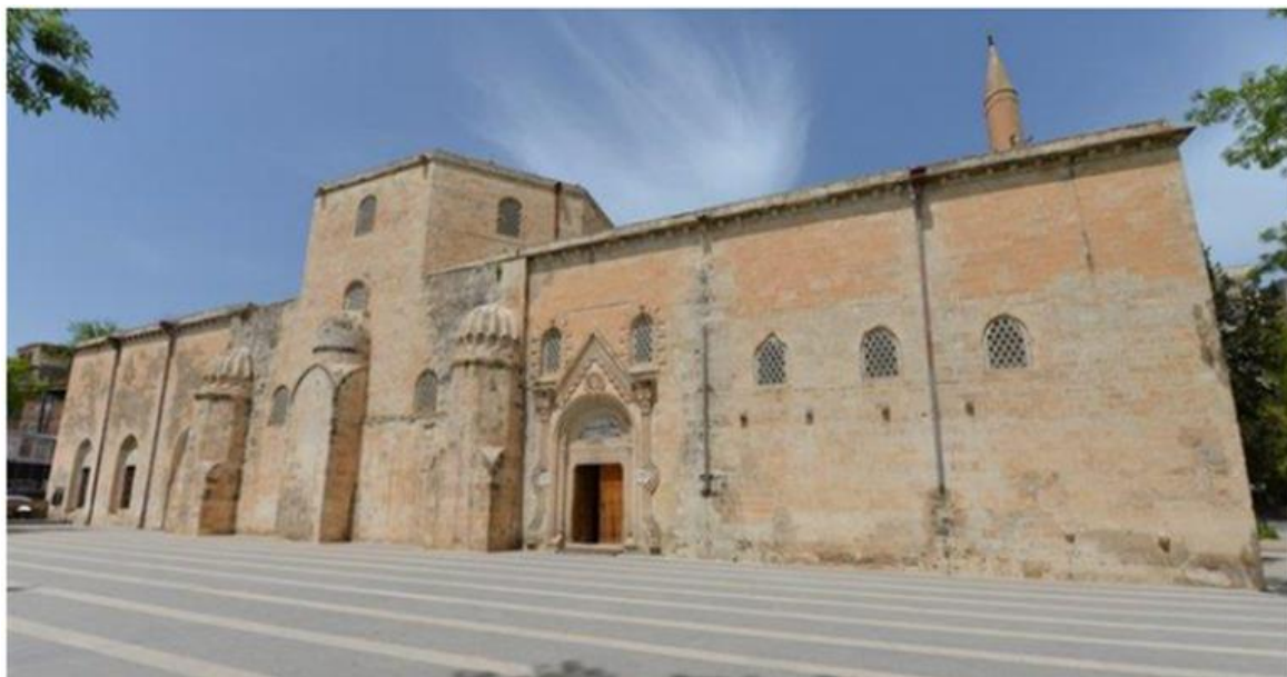
Fotoğraf 56. Diyarbakır Silvan Ulu Cami Güney Cephe (Pabuccu, 2019)
