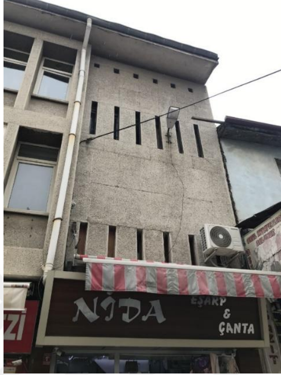
řekil 5.65. Vakıf İř Hanı ıřıklandırma ve havalandırma boşlukları (Kalkan, 2023)
