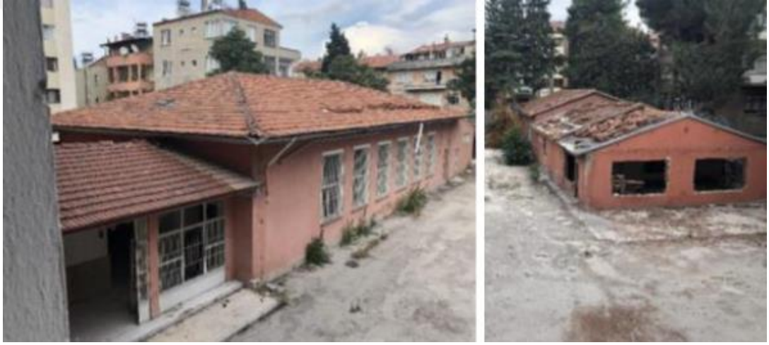
Şekil 5.41. Yapının muhdes bağlantısı ve niteliksiz ek (Şimşek Tolacı vd., 2020)
