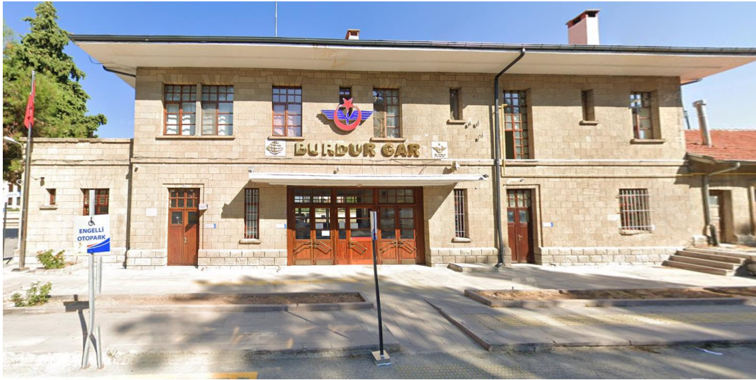
Şekil 5.58. Gar binası güney cephesi (Google Street View 2019 görüntüsü)
