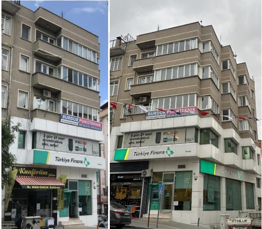
Şekil 5.30. Esdirici Apartmanı güney ve doğu cephe görselleri (Kalkan, 2023)
