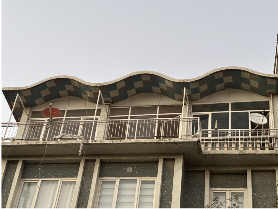
Şekil 5.11. Çöllü Apartmanı çatısı (Kalkan, 2023)
