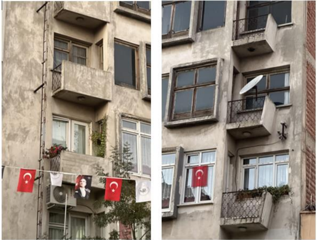
řekil 5.15. Rastgele Apartmanı balkon detayı (Kalkan, 2023)
