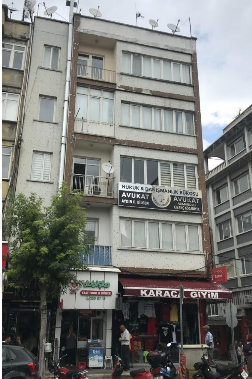
Şekil 5.20. Gür Apartmanı güney cephesi (Kalkan, 2023)
