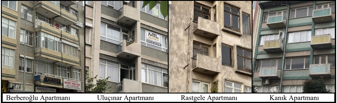
Şekil 5.77. Bir cephesi beton, bir cephesi demir korkuluklu balkonlar (Kalkan, 2023)
