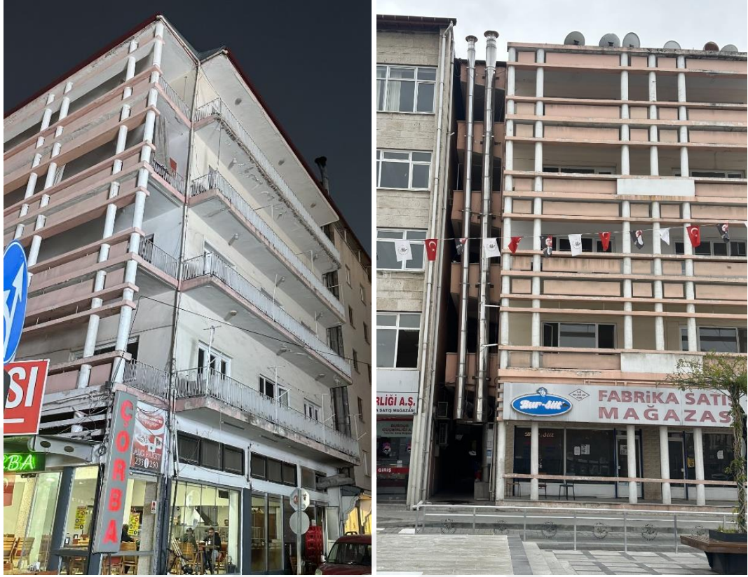
Şekil 5.56. İl Özel İdare lojman binası detay fotoğrafları (Kalkan, 2023)
