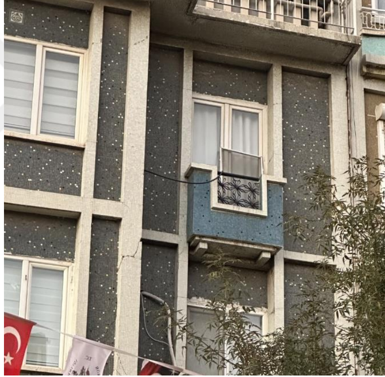
Şekil 5.9. Çöllü Apartmanı Fransız balkon detayı (Kalkan, 2023)
