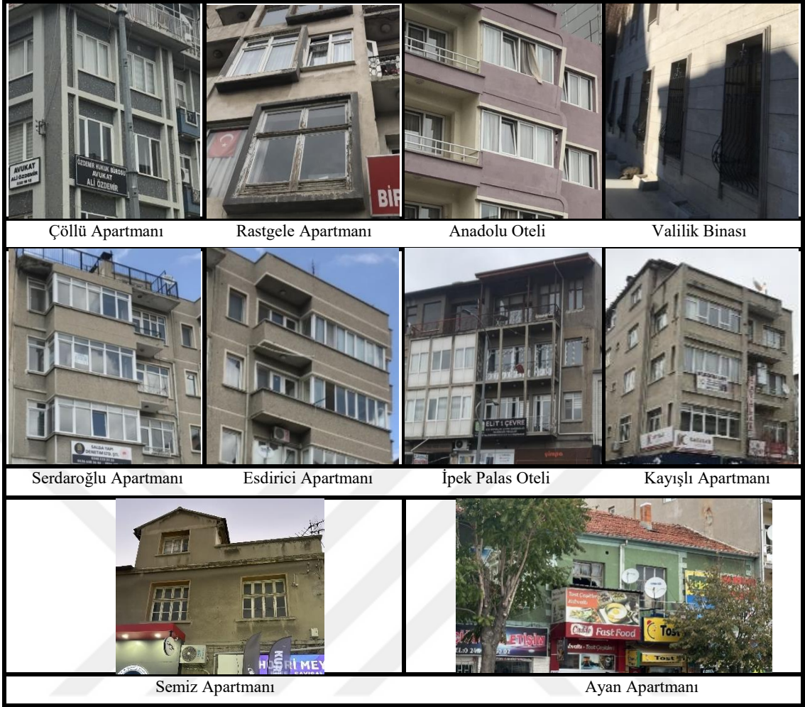
Şekil 5.84. Cephede söve kullanılan yapı görselleri (Kalkan, 2023)
