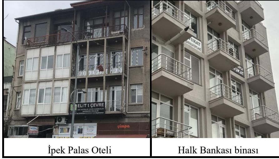
Şekil 5.76. Balkonda özgünlüğünü kaybetmiş yapı görselleri (Kalkan, 2023)
