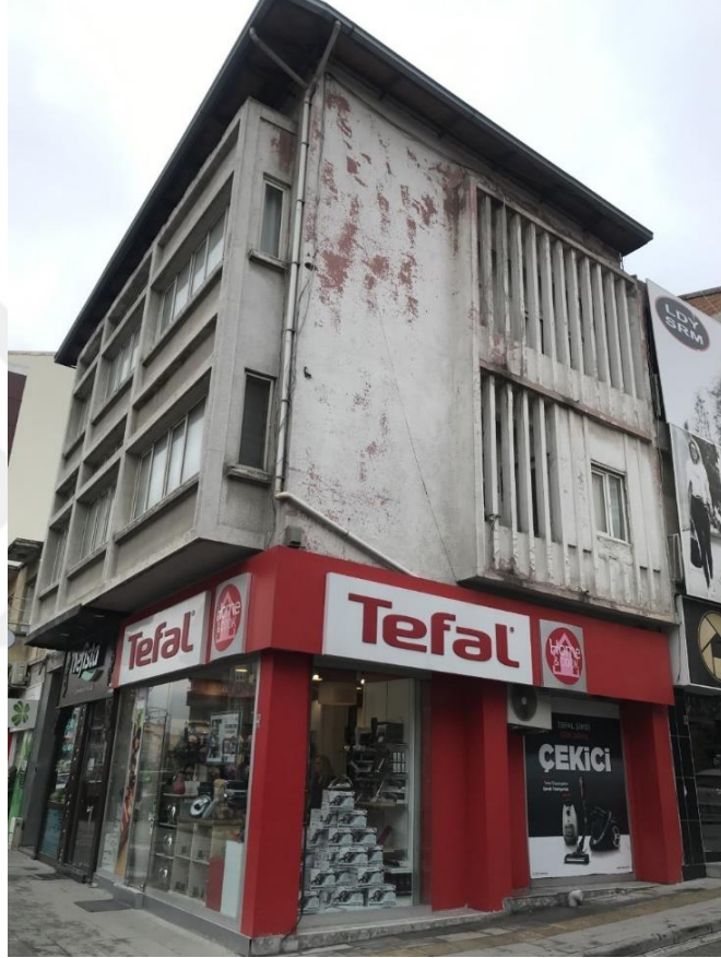
Şekil 5.19. Solmaz Apartmanı batı cephesi (Kalkan, 2023)
