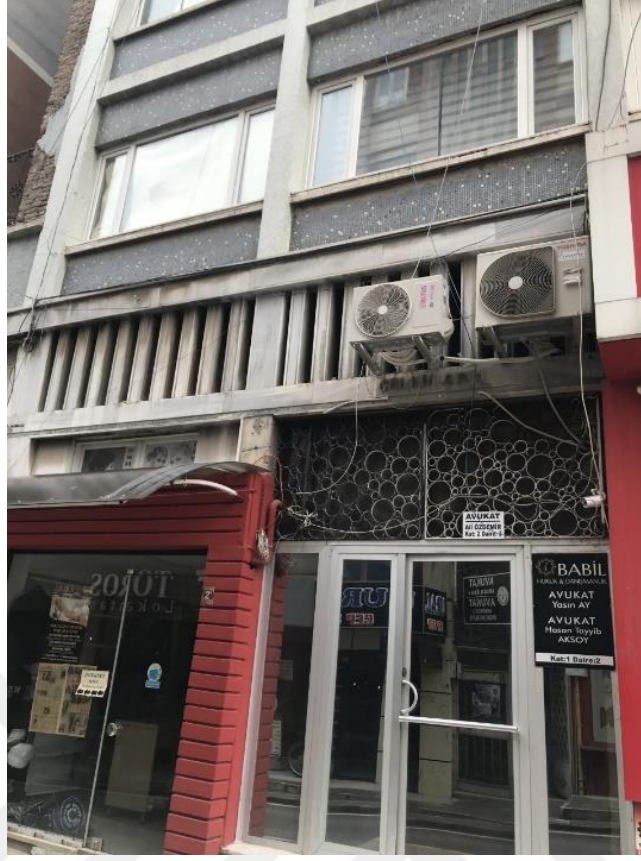
Şekil 5.10. Çöllü Apartmanı giriş kapısı detayı (Kalkan, 2023)
