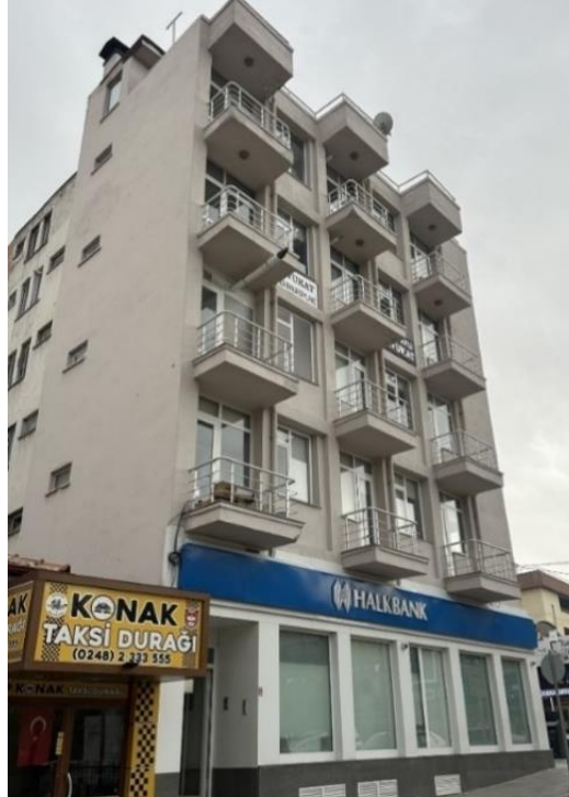
Şekil 5.39. Halk Bankası binası batı cephesi (Kalkan, 2023)
