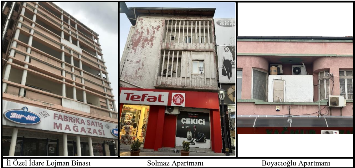
Şekil 5.79. Binalardaki gizlenmiş ve içe çekilen balkonlar (Kalkan, 2023)
