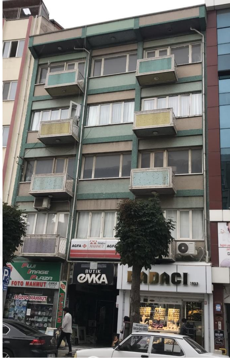
Şekil 5.29. Kanık Apartmanı (Kalkan, 2023)
