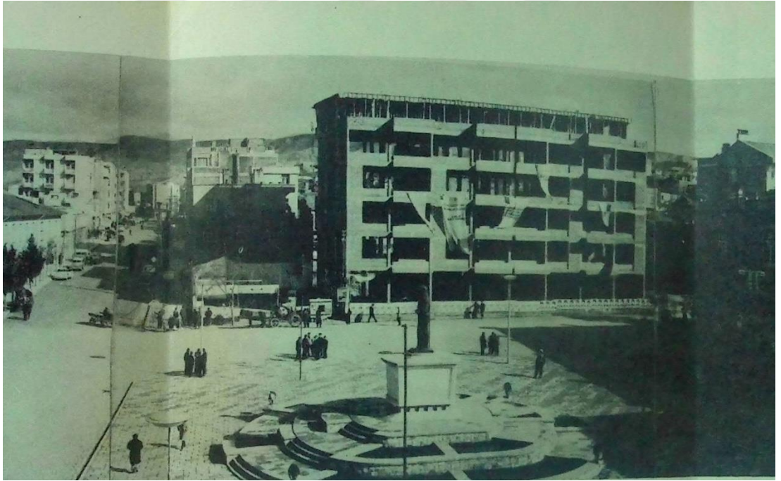
Şekil 5.16. Berberoğlu Apartmanı'nın yapım aşamasındaki görseli (Tanış, 1967)
