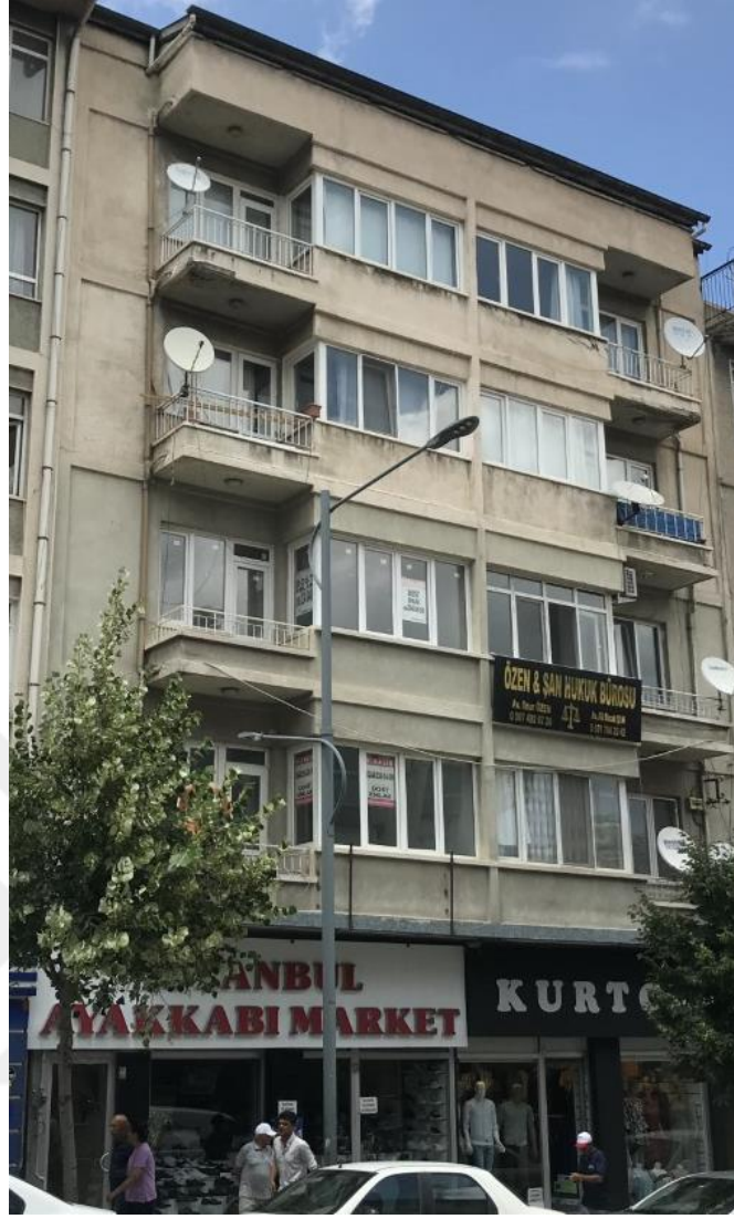
Şekil 5.32. Özmumcu Apartmanı (Kalkan, 2023)
