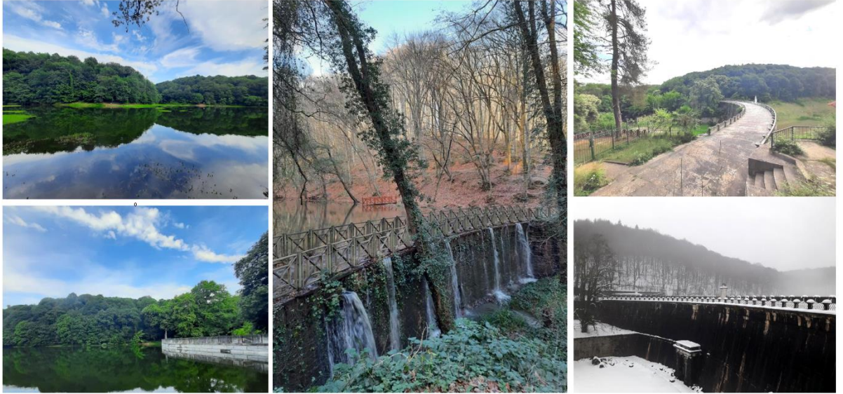
Şekil 3.9: Belgrad Ormanı bentlerinden görünümeler.
