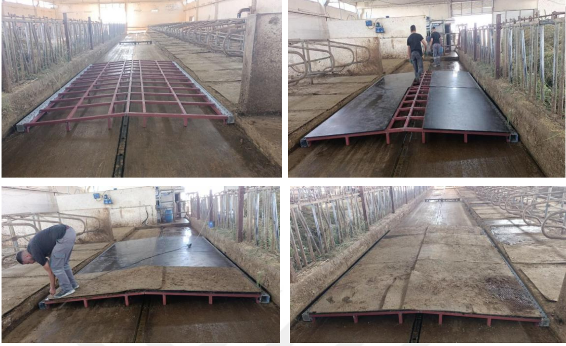
Şekil 3.3 Gübre yatağı platformunun hazırlanma aşamaları
