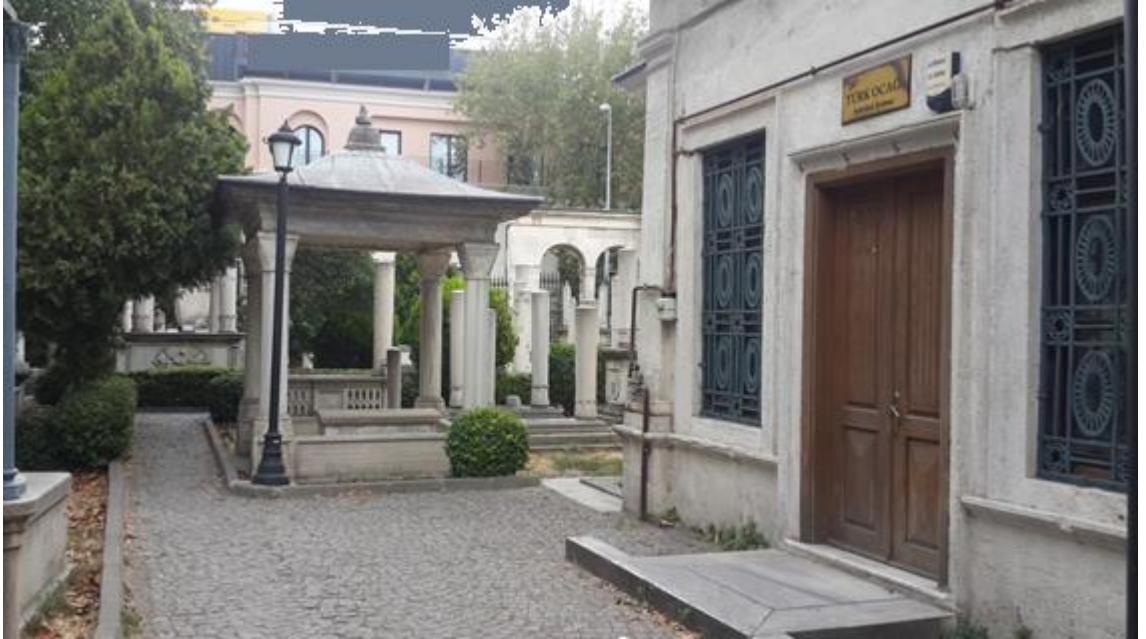
EK 7 b: Türbe Alanındaki Ocak Binası Girişinin Farklı Açılardan Görünüşü.
