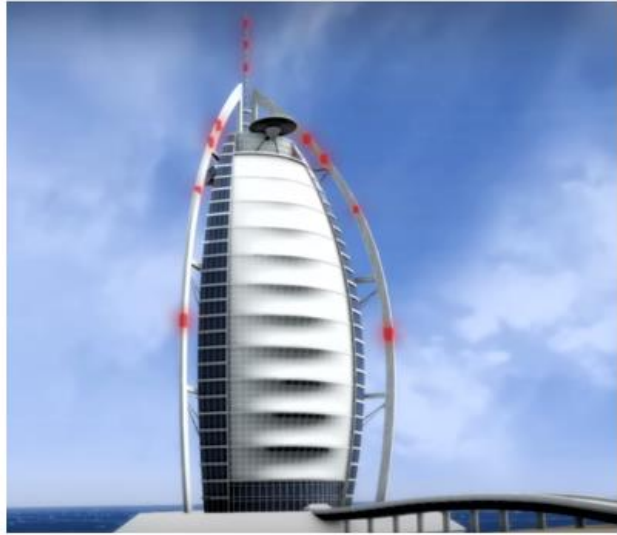
Şekil 2.3: a) Burj Al Arab ve b) Yapının dışında bulunan ayarlı kütle sönümleyiciler 1 .
