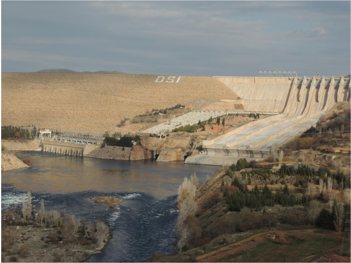
Şekil 8. Keban Barajı'ndan bir görünüm (Kasım,2023)
