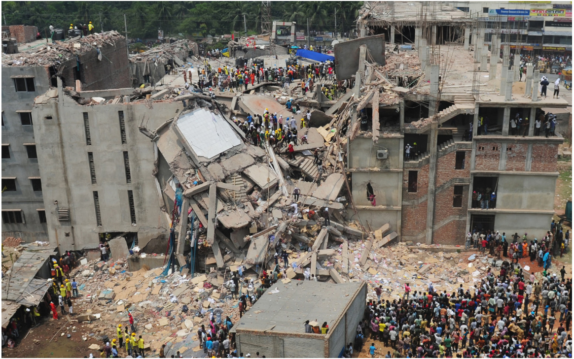
Resim 8. Rana Plaza Binası Yıkıldıktan Sonra
