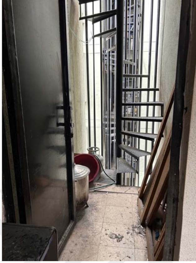
Şekil 3.19: Boyamanın yapıldığı yangın merdivenleri (Gülbahar Gümüşten Çelik Arşivi).
