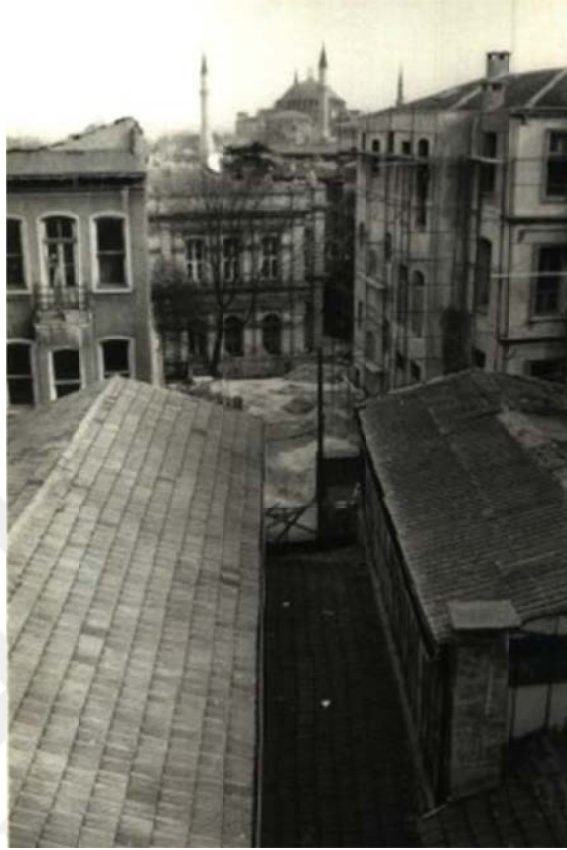
Şekil 2.13: Babıali Halıcılar Çarşısı binası ve birleştirilip yeniden inşa edilen diğer iki bina (İstanbul 4 Numaralı Kültür Varlıklarını Koruma Bölge Kurulu Müdürlüğü Arşivi, 2022).
