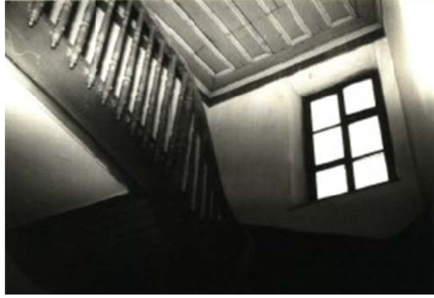
Şekil 2.14: Recondüksüyon öncesi kâgir yapıda olan binanın iç kısmı (İstanbul 4 Numaralı Kültür Varlıklarını Koruma Bölge Kurulu Müdürlüğü Arşivi, 2022).
