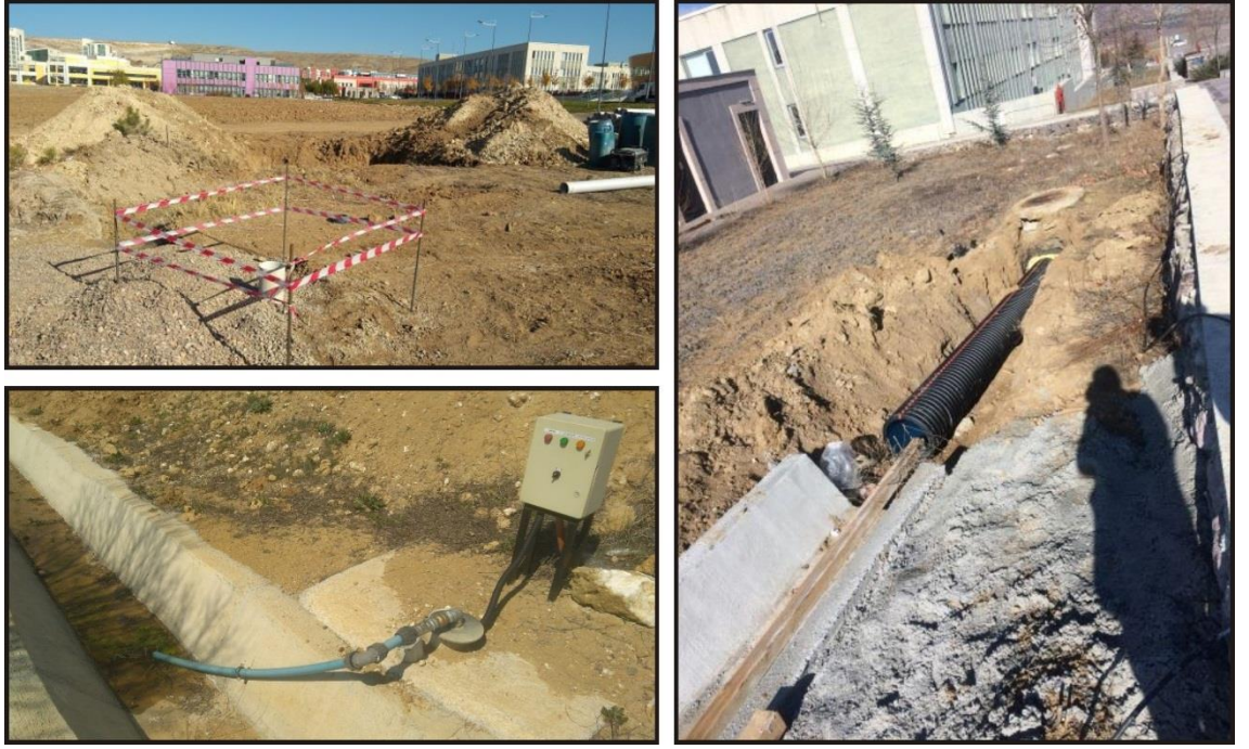
Şekil 4.28 Yeraltı suyunun tespiti ve tahliyesi ile ilgili çalışmalar
