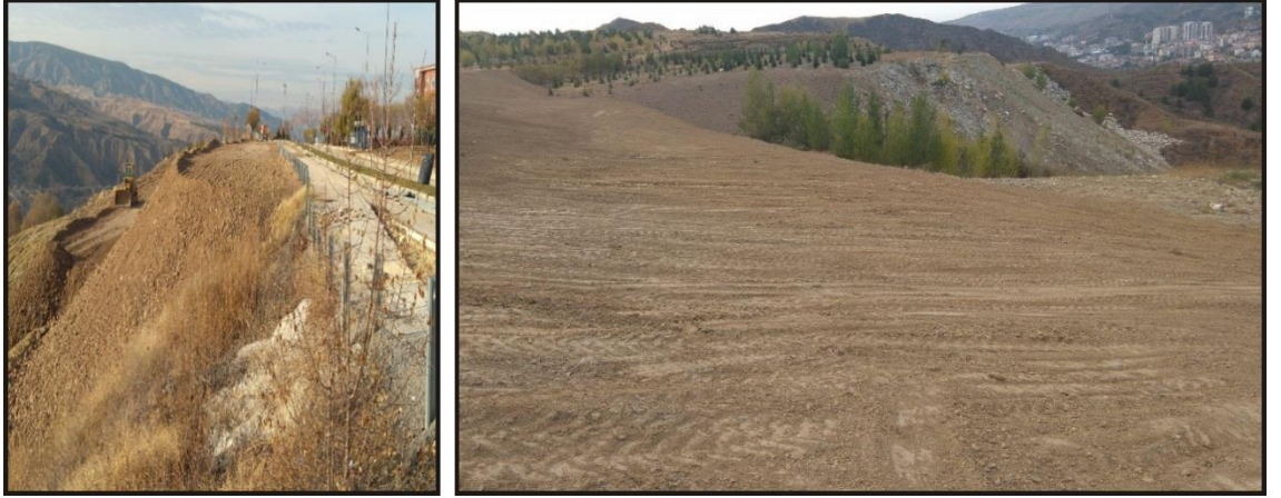
Şekil 4.42 Heyelan bölgesi eğim azaltma çalışmaları
