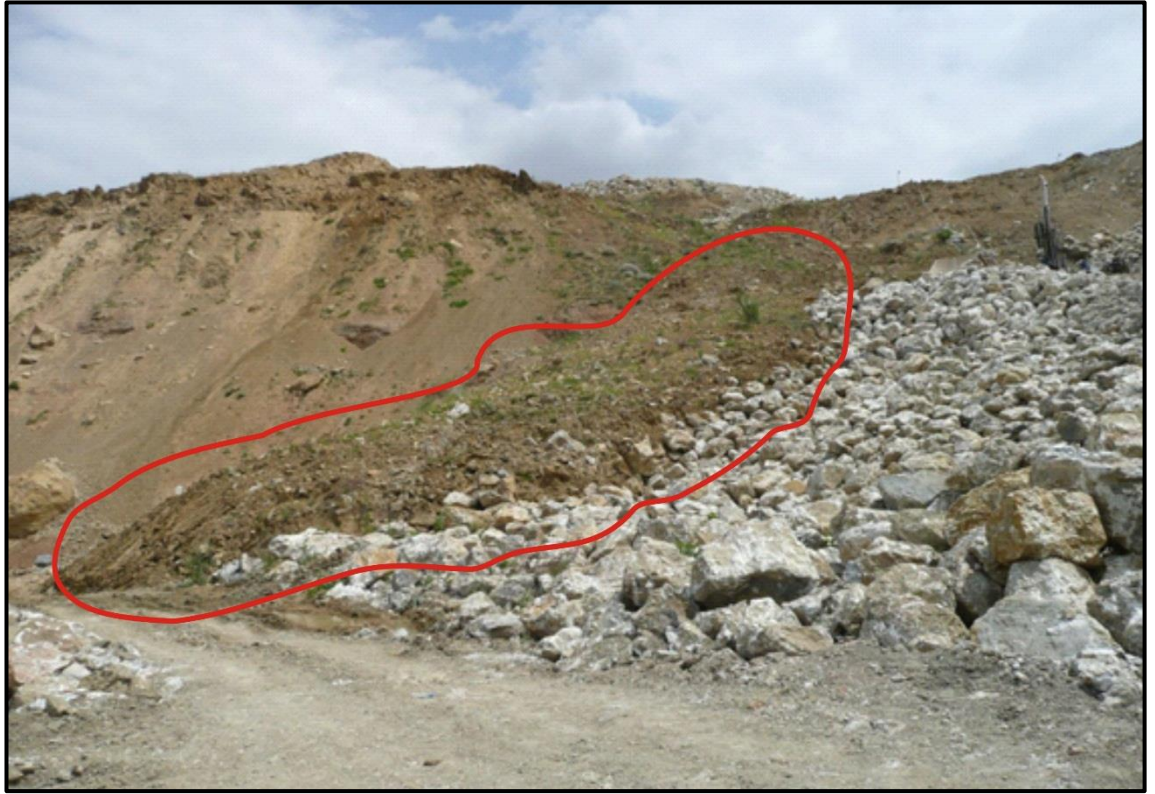
Şekil 4.6 Heyelan topuğundaki yüzeysel akmlar
