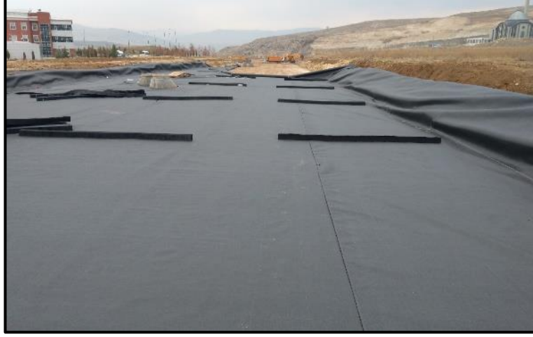
Şekil 4.16 Uluyazı Kampüsü yol yapımında kullanılan geomembran
