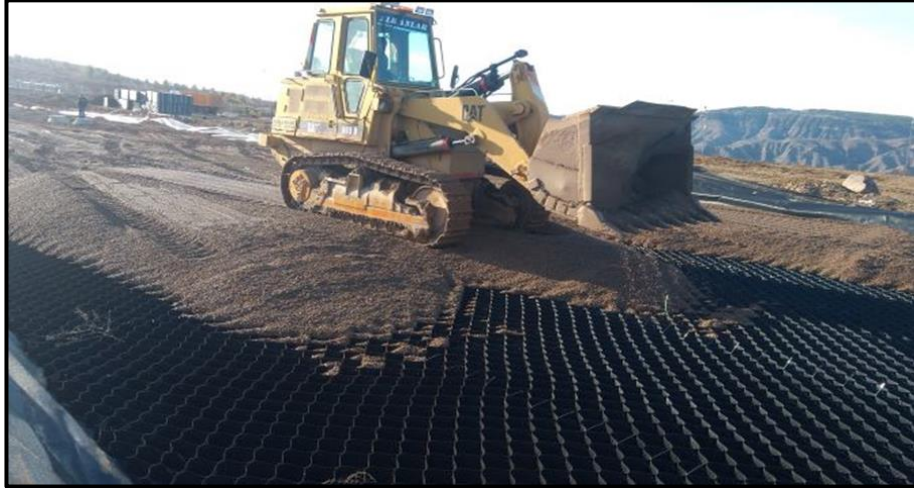
Şekil 4.38 Serilen geocell hücrelerinin filtrasyon agregası ile doldurularak sıkıştırılması
