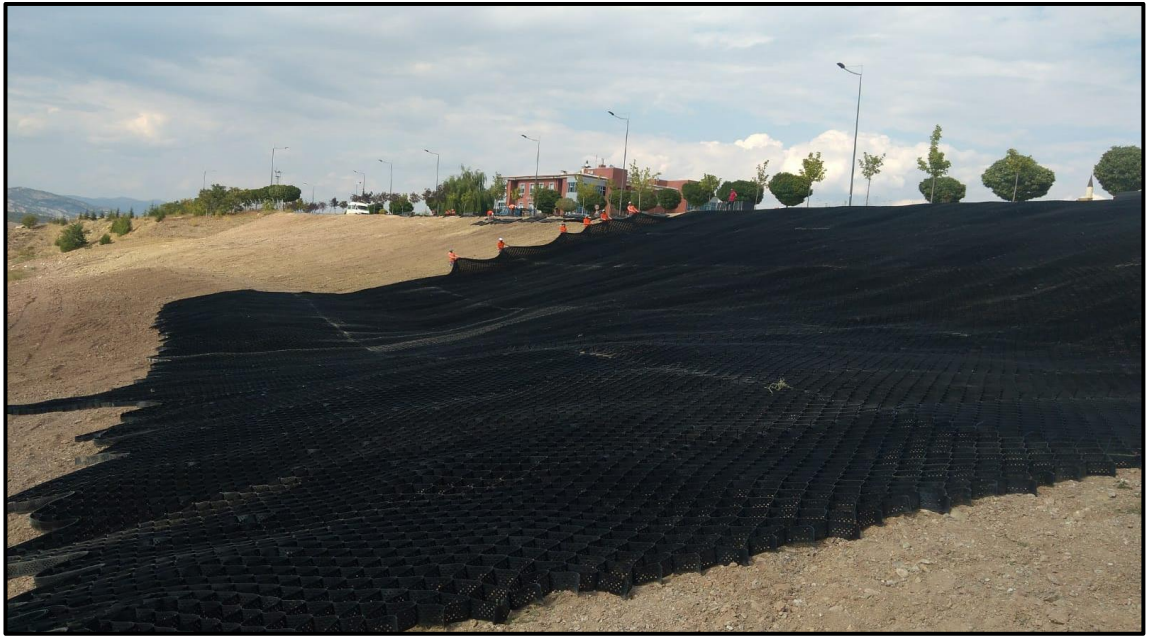
Şekil 4.18 Uluyazı Kampüsü heyelan bölgesine ait geohücre uygulamasına ait görüntü
