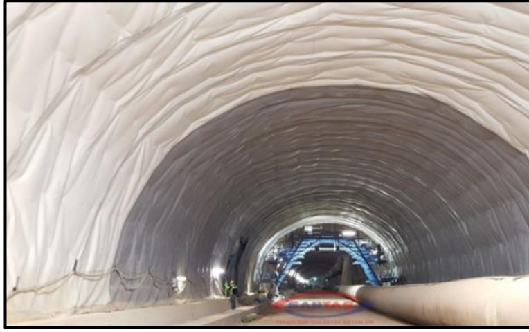
Şekil 4.14 Tünellerin içinde geçirimsizliği sağlamak (Url-2)
