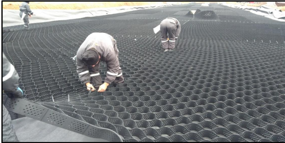
Şekil 4.36 Akordeon şeklinde açılan geohücrenin birleştirilmesi
