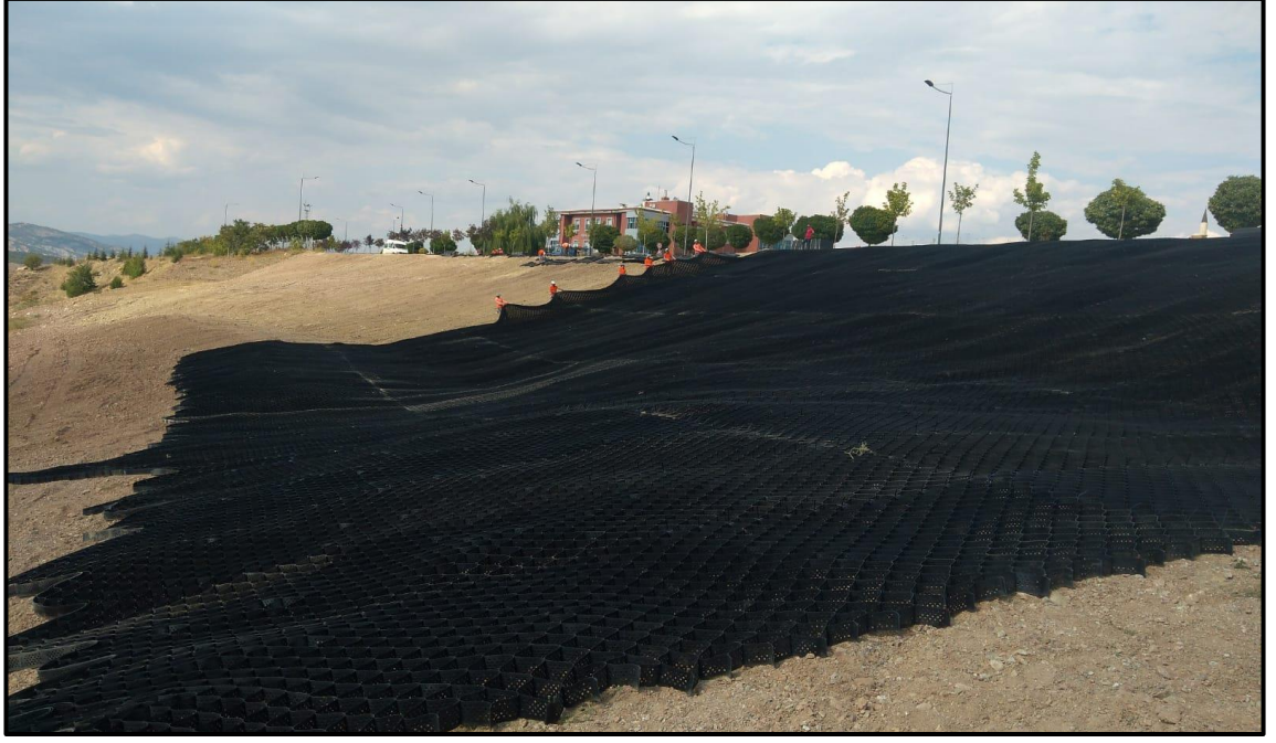
Şekil 4.44 Hücresel dolgunun serilmesi
