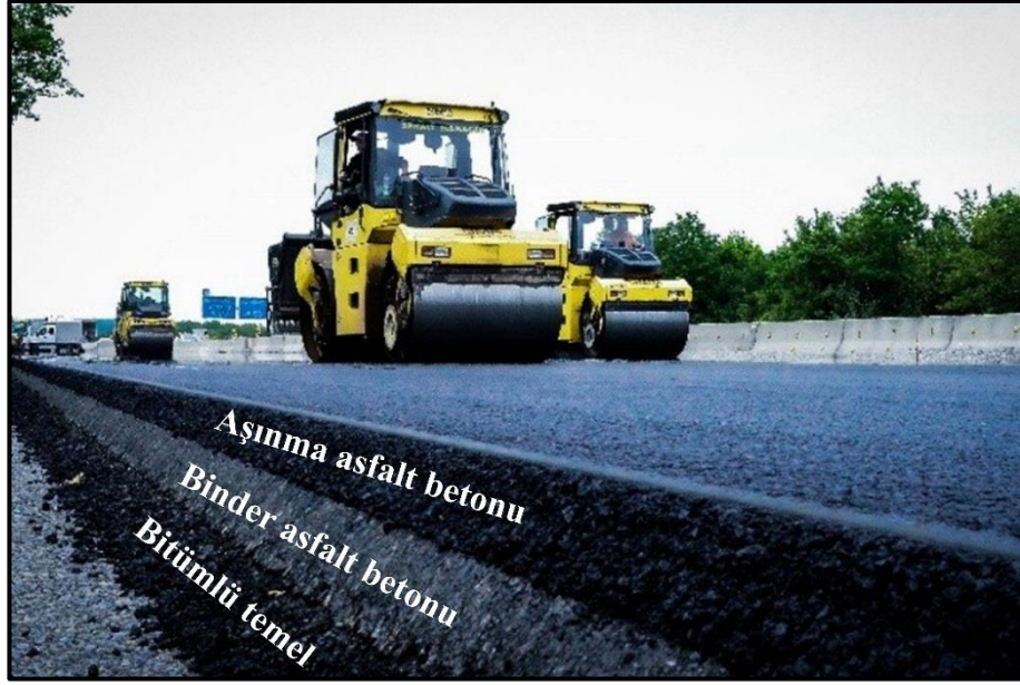
Şekil 4.41 Karayollarında kullanılan asfalt tabakaları
