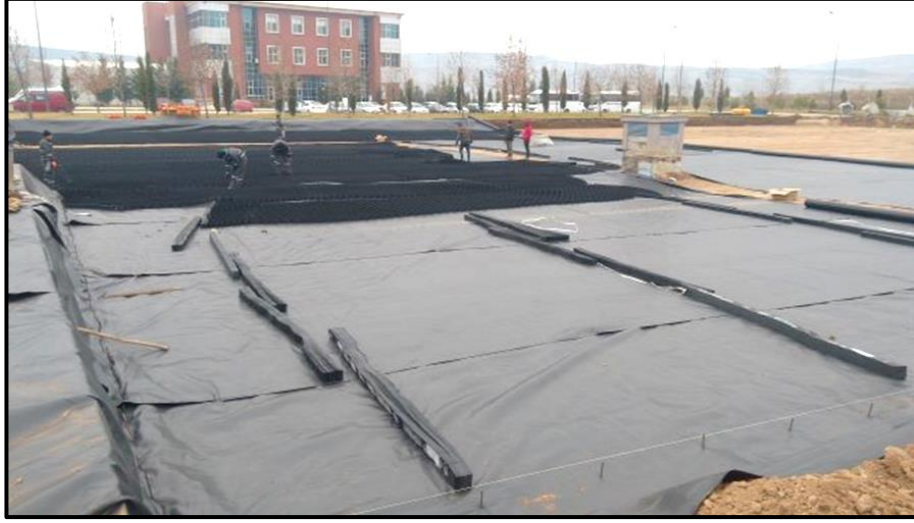
Şekil 4.35 Kapalı olan geohücrenin akordeon şeklinde açılarak geomembranın üzerine serilmesi
