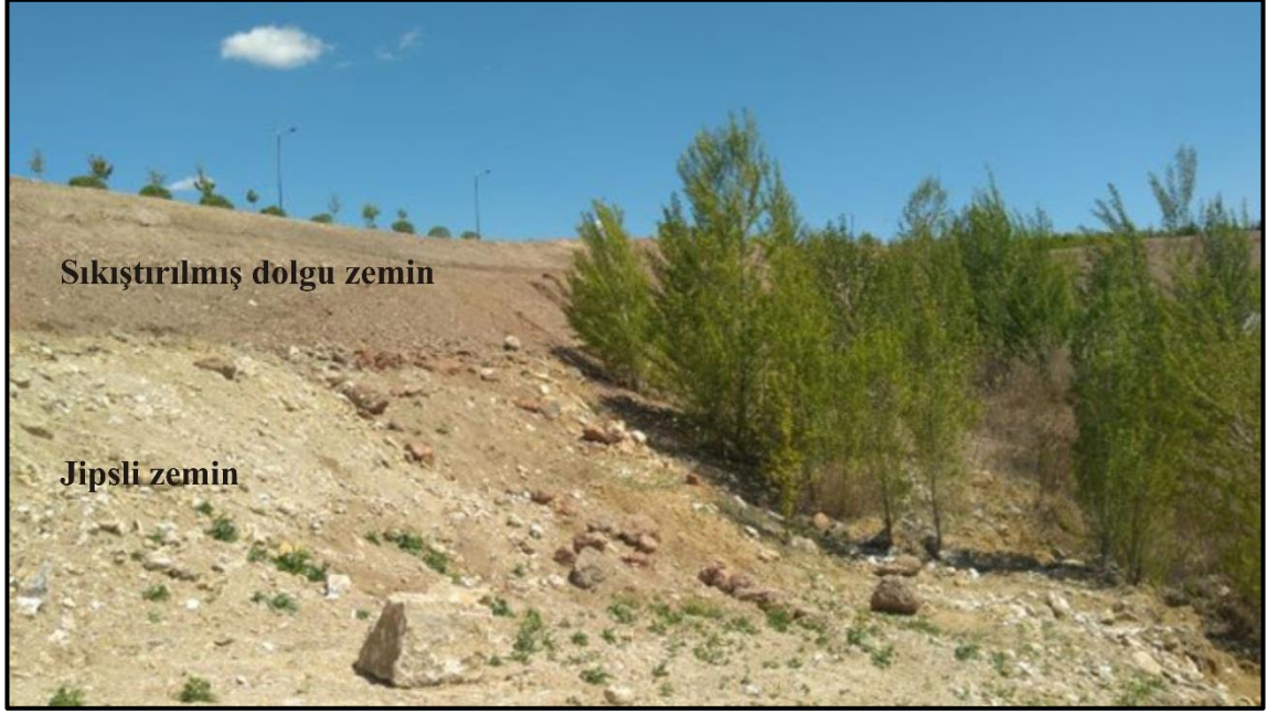
Şekil 4.43 Şev dolgusu iyileştirme çalışmaları
