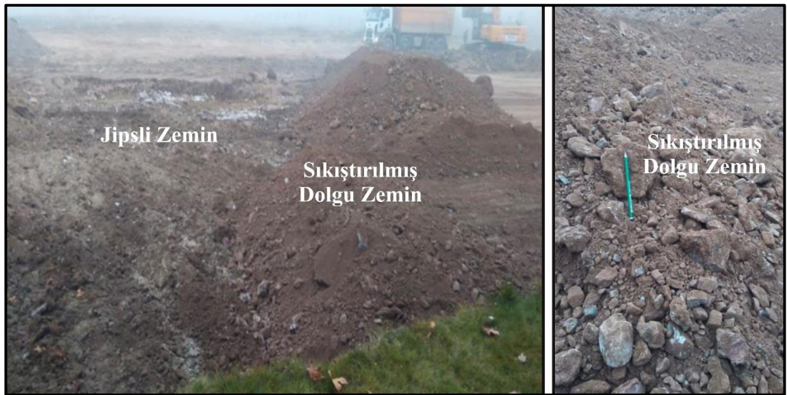
Şekil 4.32 Jipsli zeminin kazılarak yerine sıkıştırılmış dolgunun serilmesi
