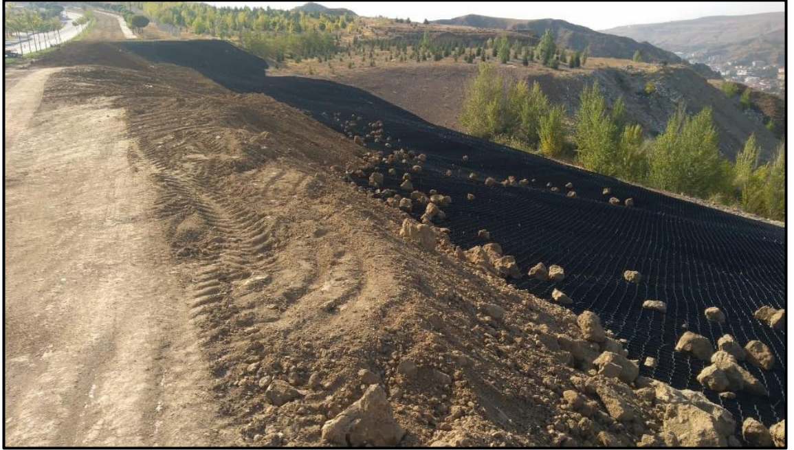
Şekil 4.45 Hücresel dolgu üzerine bitkisel toprağın serilmesi
