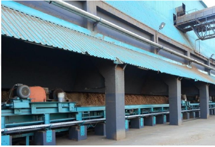
Şekil 2.17. Beton yonga silosu
