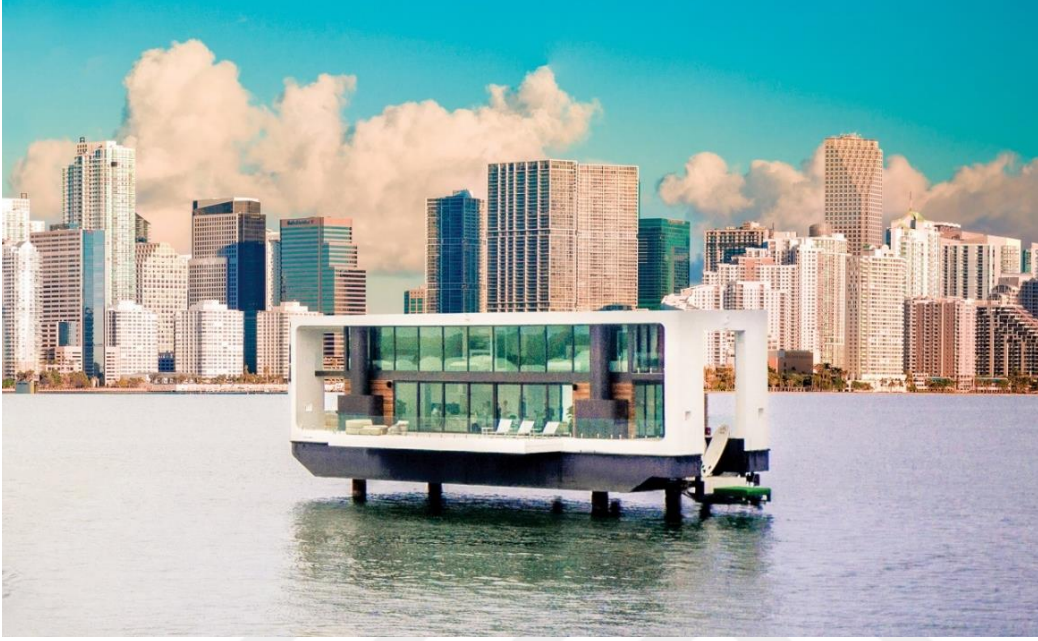
Şekil 3.18 : Arkup 75’in hidrolik sütunlar yardımıyla deniz seviyesinden yükselmesi (Url-18).
