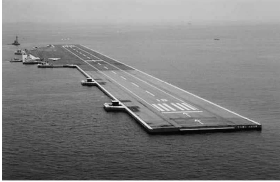
Şekil 3.11 : Tokyo Körfezi’nde tasarlanan ilk yüzen pist (megafloat) prototipi (Url-11).
