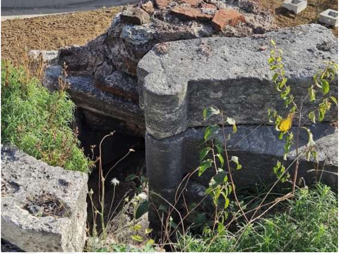
Resim 17. Mevlanakapı kule merdivenleri yukarıdan görünüm. Günümüze orijinal hali ile ulaşmış diğer merdivenlerden kule üzerine çıkmak mümkündür. (Yazarın kendi arşivi, 2023)
