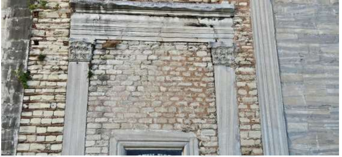
Resim 10. Altın Kapı'dan detay: Geç Bizans dönemi dolgusu: Bu son dolgunun ardından kapı açıklığı küçük bir geçite dönüşmüştür. (Asutay-Effenberger, 2017) (Yazarın kendi arşivi, 2023)
