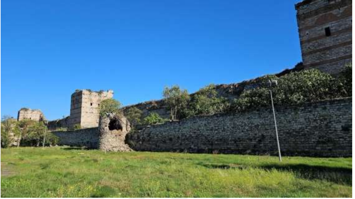
Resim 2. Dış duvar kuleleri İç duvar kulelerinin ortasında kalacak şekilde inşa edilmiştir. (Yazarın kendi arşivi, 2023)
