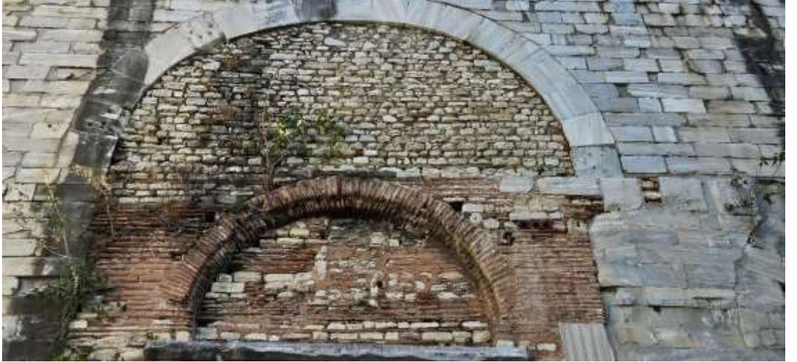
Resim 9. Altın Kapı'dan detay: Orta açıklıkta görülen iki farklı dolgu yöntemi (AsutayEffenberger, 2017). (Yazarın kendi arşivi, 2023)
