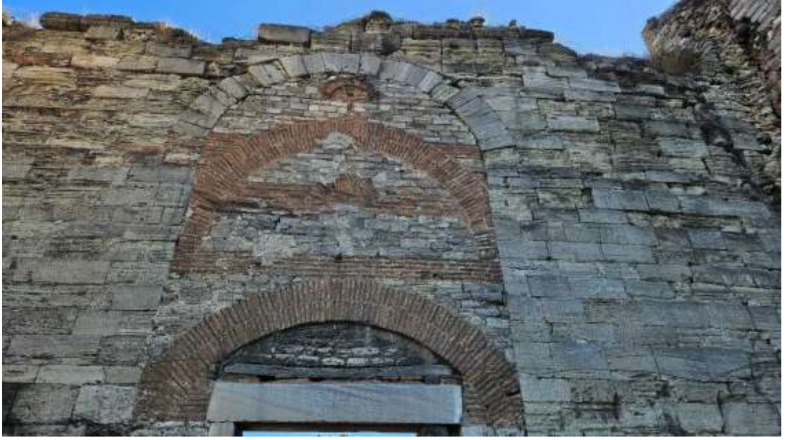
Resim 24. Sulukule İçerden: Duvar işçiliğindeki farklılıklar kapının başka zamanlarda örüldüğünü göstermektedir. (Asutay-Effenberger, 2017) (Yazarın kendi arşivi, 2023)
