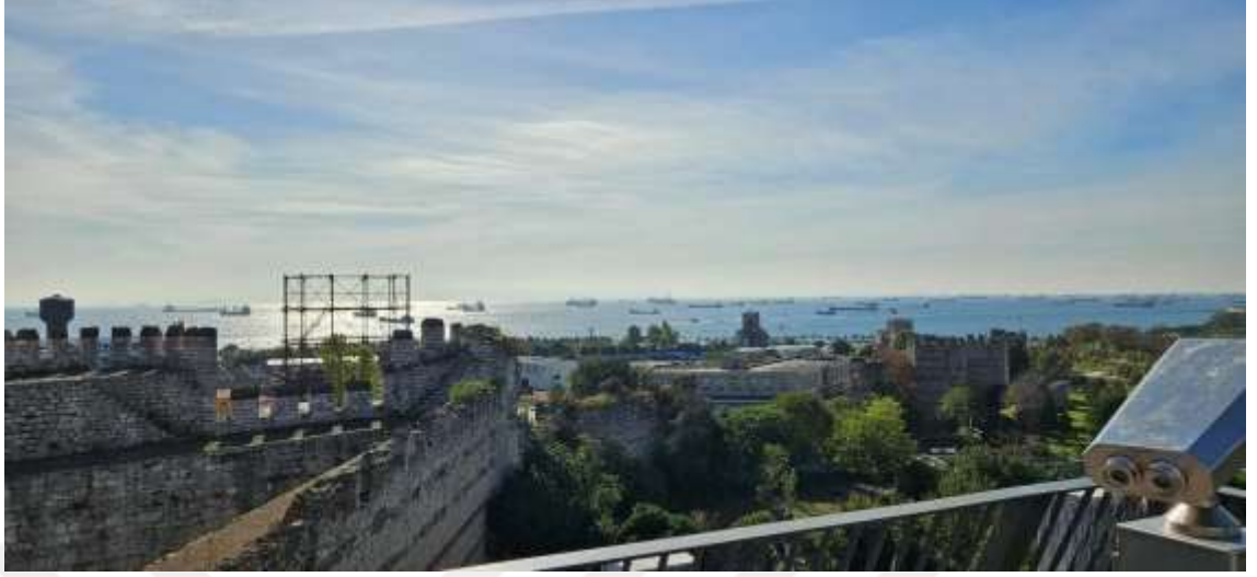
Resim 7. Altın Kapı Kuzey Kule Üzerinden: Günümüzde Perde duvar boyunca Hisar'ın köşesine kadar yürümek mümkündür. Denize kadar uzanan ve Geç Bizans döneminde tahkim edilmiş ancak belirli noktaları Sultan Bayezid'in baskıları sonucu yıktırılmıştır. (Haz.Kabasoy, 2021) (Yazarın kendi arşivi, 2023)
