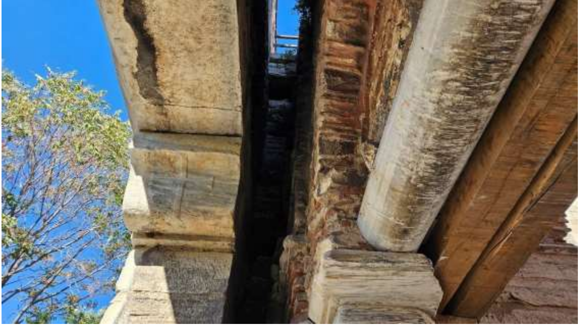
Resim 52. Mevlanakapı Dış. Savaş zamanında kapıyı mühürlemek için indirilen demir mazgalın yuvası günümüze ulaşmıştır. (Asutay-Effenberger, 2017) (Yazarın kendi arşivi, 2023).
