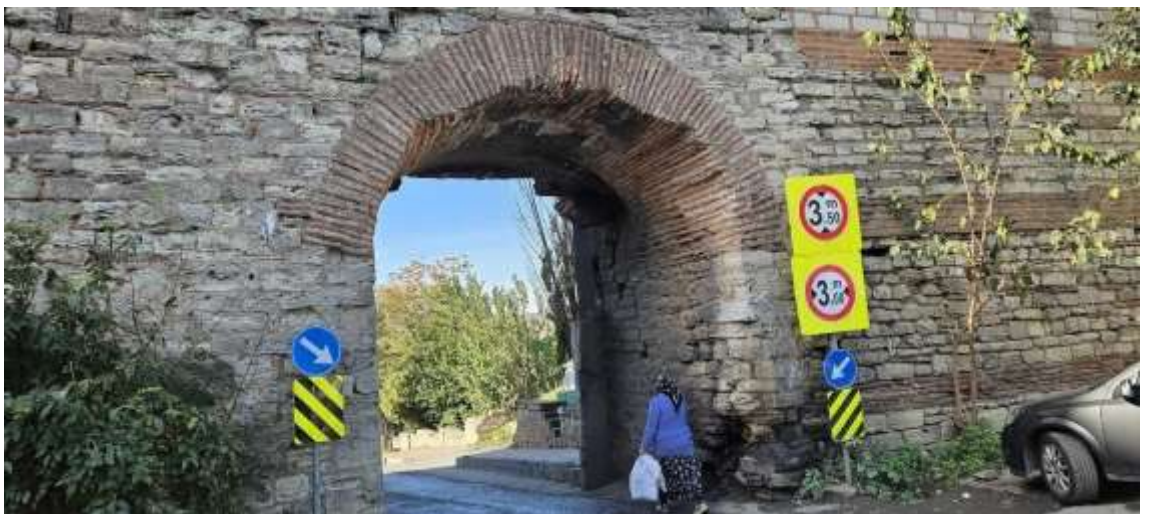
Resim 11. Yedikule Kapısı şehir tarafından görünüm. Kapı kemerleri ile Kuzey yönde kalan beş sıra tuğlanın aynı hizada bulunması nedeniyle kapının Osmanlı döneminde açılmış olabileceği iddiası reddedilmiştir (Haz. Kabasoy, 2021) (Yazarın kendi arşivi, 2023)
