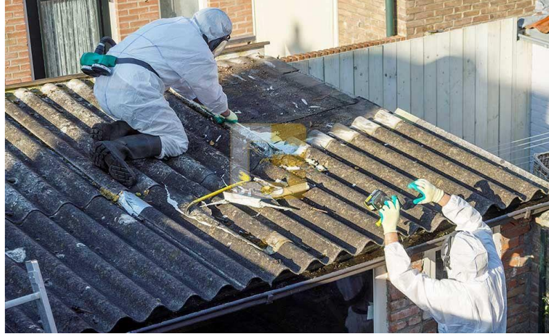
Şekil 2.18: Eternit Kaplamalarında Asbest Sökümü
