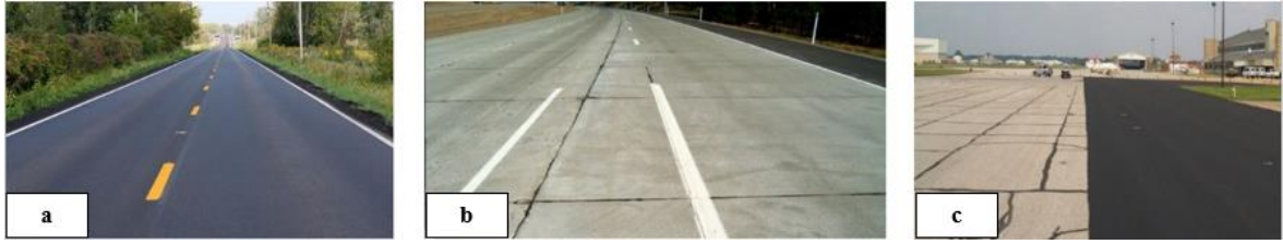
Şekil 2.2. Karayollarında yaygın olarak kullanılan kaplama türleri (Alimohammadi ve diğerleri, 2021)
