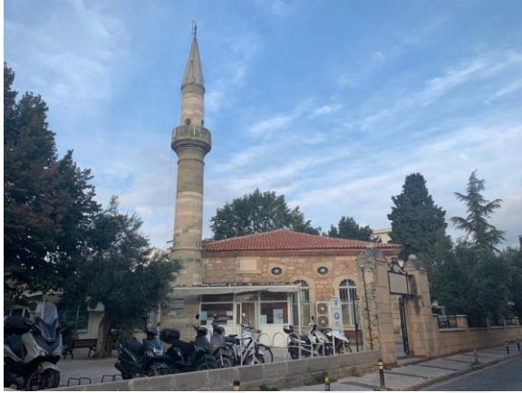
Resim 3.42. Tıflı Cami (Fotoğraf 08.09.2023 tarihinde çekilmiştir)
