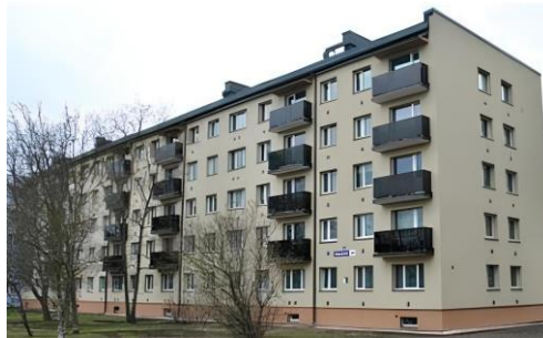
Şekil 4.26 : Mustamäe Bölgesi Apartmanı cephe yenilemesi sonrası durumu (Borodiņecs vd., 2013)
