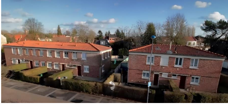
Şekil 4.17 : Hem Apartman Binaları cephe yenilemesi öncesi durumu (Url-13)
