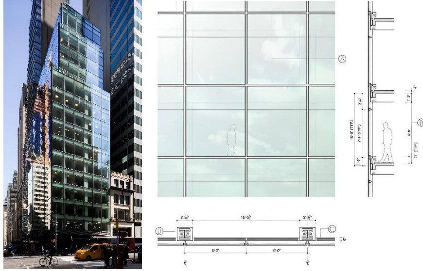
Şekil 4.2 : 545 Madison Avenue binasının cephe yenilemesi sonrası durumu (Url-6)
