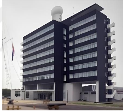
Şekil 4.5 : Albatros Konut Binası cephe yenilemesi sonrası durumu (Url-7)
