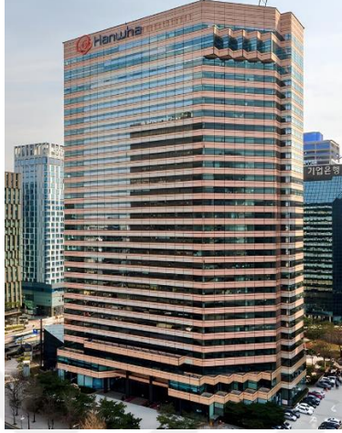
Şekil 4.14 : Hanwha Headquarters Tower cephe yenilemesi öncesi durumu (Url-11)
