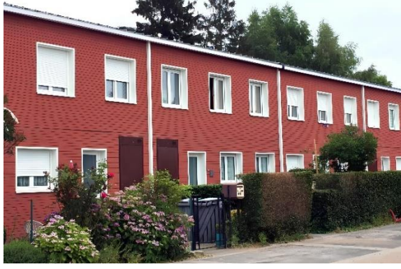
Şekil 4.19 : Hem Apartman Binası cephe yenilemesi sonrası durumu (Url-13)
