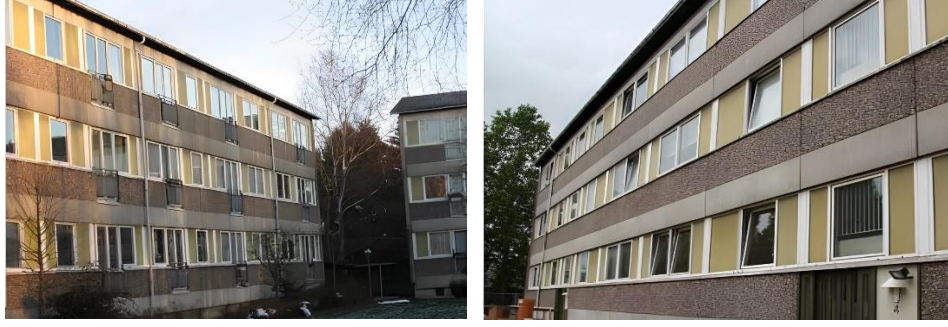
Şekil 4.36 : Traneparken Apartman Binası cephe yenilemesi öncesi durumu (Höfler vd., 2017)
