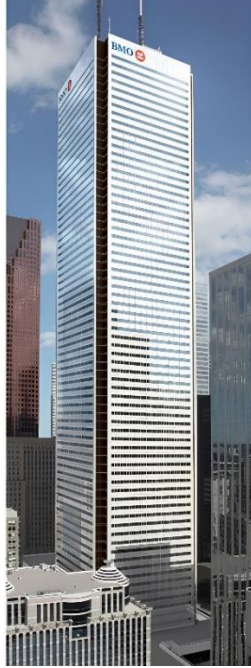
Şekil 4.13 : First Canadian Place cephe yenilemesi sonrası durumu (Url-9)
