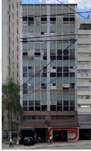
Şekil 4.33 : Trabulsi Binası cephe yenilemesi öncesi durumu (Url-18)
