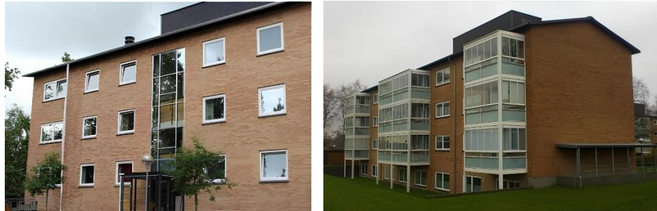
Şekil 4.37 : Traneparken Apartman Binası cephe yenilemesi sonrası durumu (Höfler vd., 2017)
