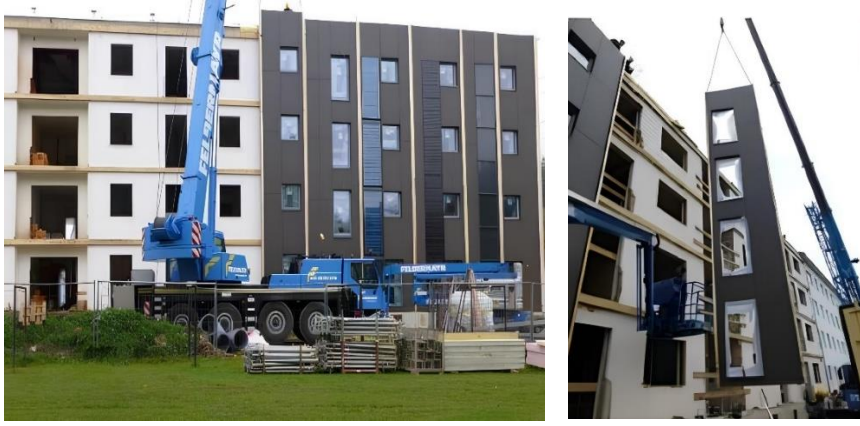
Şekil 4.21 : Mevcut cepheye ilave yapılan yenileme müdahaleleri (Höfler vd., 2014)
