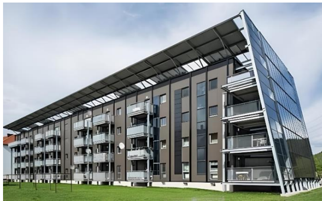
Şekil 4.22 : Johann Böhm Sanierung Konut Kompleksi cephe yenilemesi sonrası durumu (Url-14)
