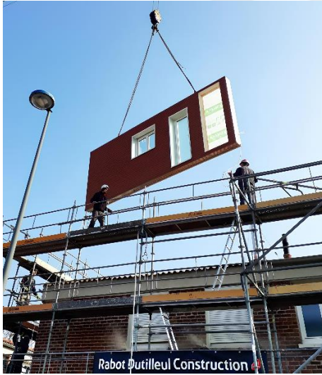
Şekil 4.18 : Prefabrike cephe panellerinin montajı ve katmanları (Url-13)
