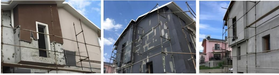
Şekil 4.7 : Cephe yenileme aşaması (Şenel, 2021)
