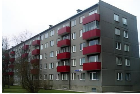
Şekil 4.25 : Mustamäe Bölgesi Apartmanı cephe yenilemesi öncesi durumu (Borodiņecs vd., 2013)
