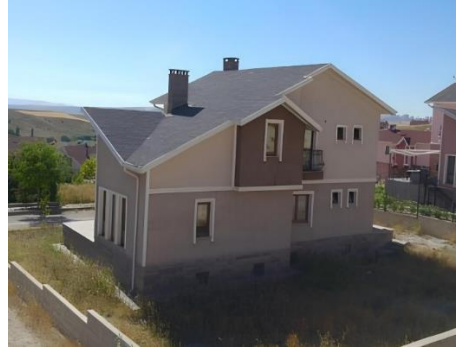
Şekil 4.6 : Ankara Pasif Ev cephe yenilemesi öncesi durumu (Şenel, 2021)
