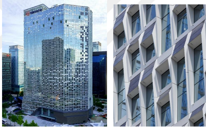
Şekil 4.16 : Hanwha Headquarters Tower cephe yenilemesi sonrası durumu (Url-11)
