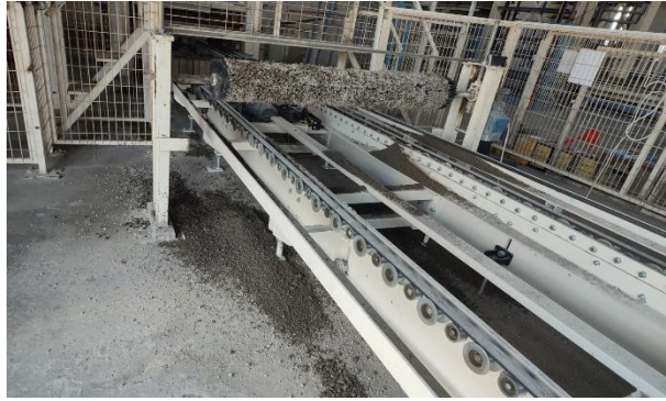
Şekil 3.7. Briket tuğla üretimi sonrası ortaya çıkan atık malzeme
