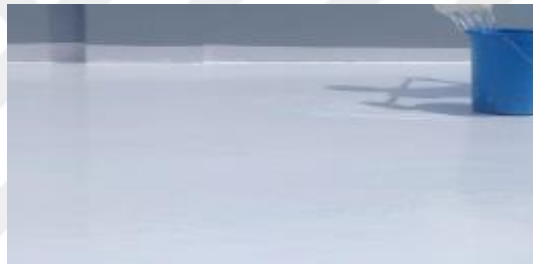
Şekil 1.4. Epoksilerin teras çatı yalıtımında kullanılması
