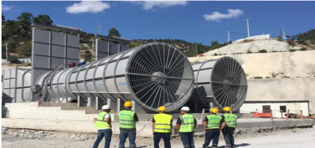
Şekil 2.23: Yeraltı Maden Havalandırma Mekanizması (İSG Tedbir, 2016).
