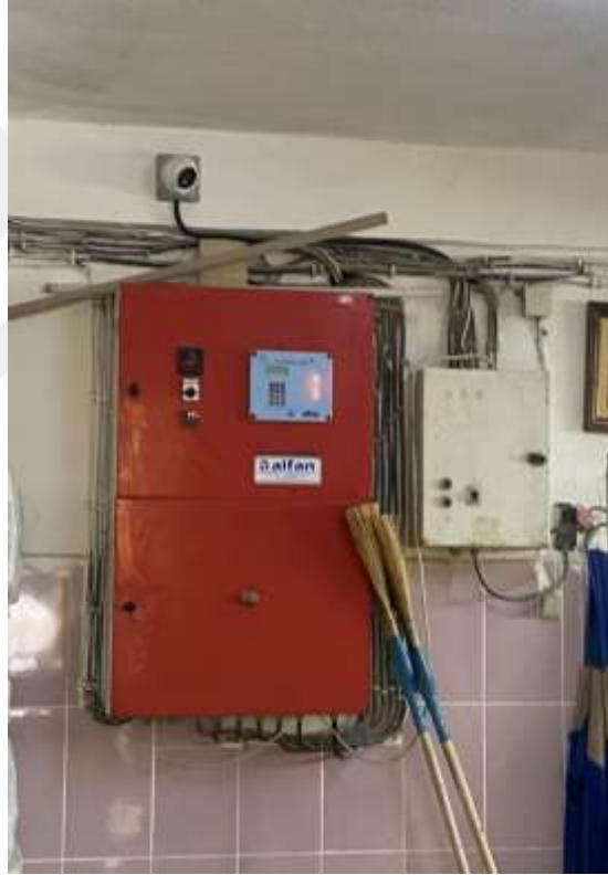
Şekil 3.4. Gül-Tav Üretim Çiftliğinde Kullanılan Fan ve Isı Sıcaklık Panosu.
