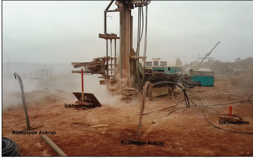
Şekil 5. 16 İnklinometre kuyuları ve reaksiyon ankrajları delgisi
