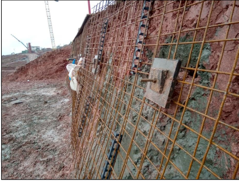
Şekil 5. 21 Hasır çelik yerleştirilmesi
