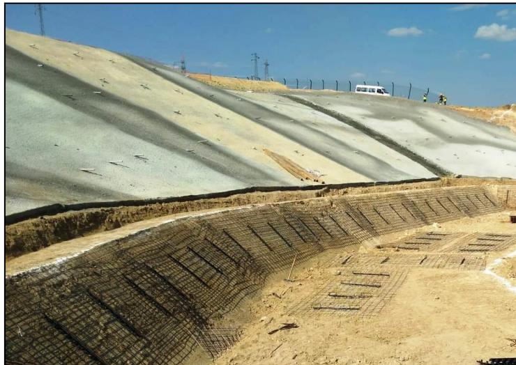
Şekil 3. 2 Şevli açık kazı yöntemi [16]
