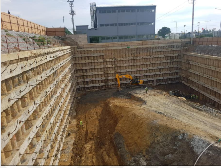
Şekil 3. 9 Ankrajlı kazı yöntemi [16]
