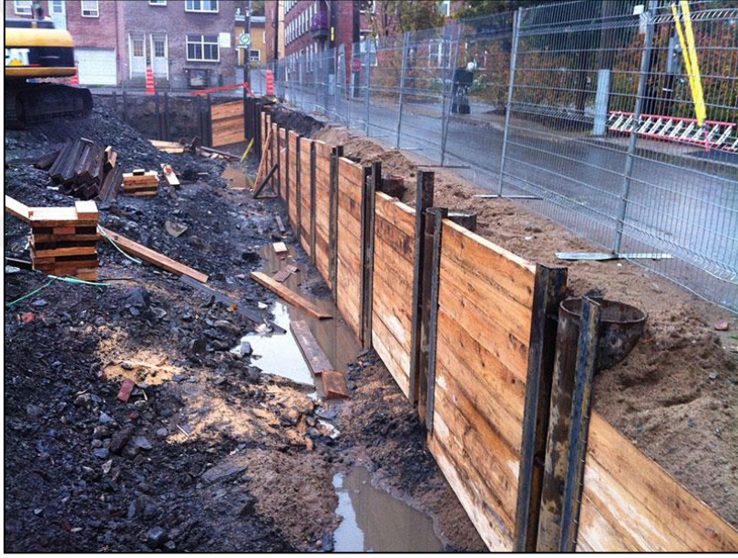
Şekil 3. 4 Berlin wall kazı yöntemi [17]
