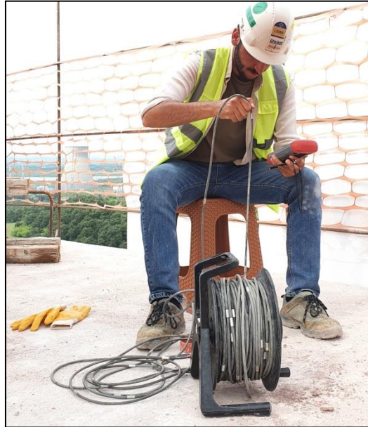
Şekil 5. 30 İnklinometre okuma yapılması
