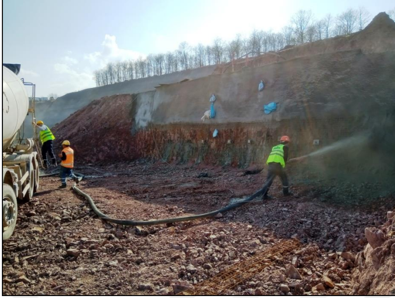
Şekil 5. 22 Püskürtme beton uygulanması
