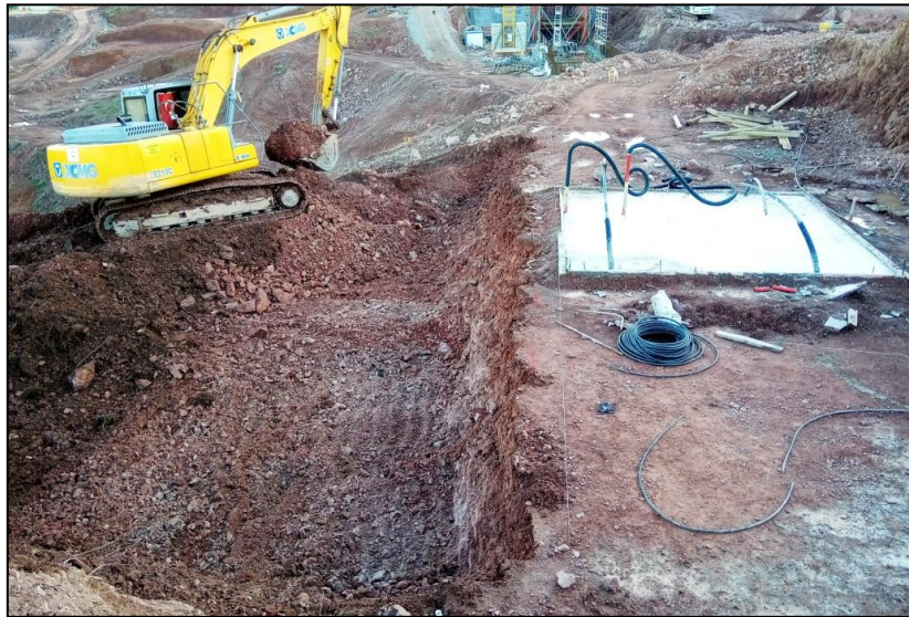
Şekil 5. 17 İlk kademe kazı yapılması
