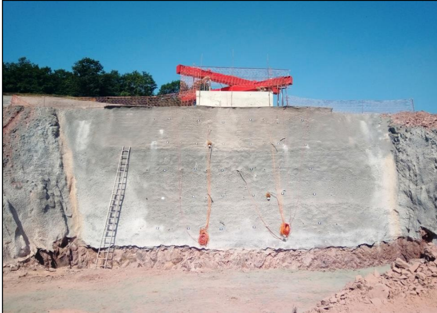
Şekil 5. 23 Deney sahası nihai kazı durumu önden görünüşü
