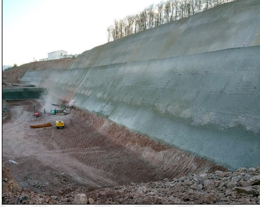
Şekil 3. 13 Zemin çivili püskürtme betonlu iksa görüntüsü [16]
