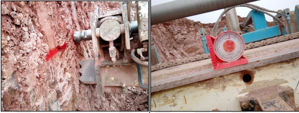
Şekil 5. 18 Çivi delgisi ve terazi işlemi
