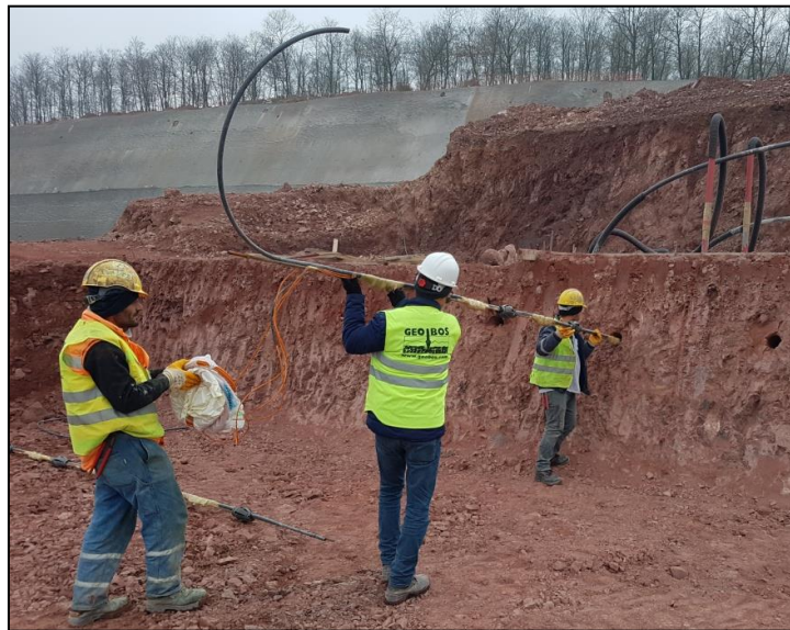
Şekil 5. 19 Çivilerin kuyuya yerleştirilmesi
