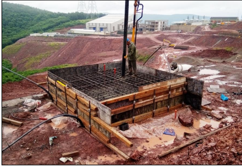
Şekil 5. 25 Betonarme başlık plağı yapımı
