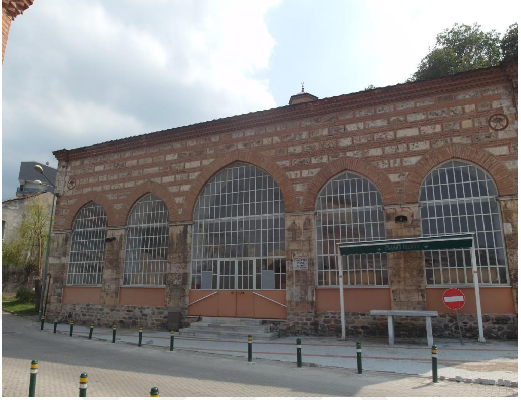
Fotoğraf 21. Bursa Timurtaş Paşa Camii'nin Kuzey Cephesinden Genel Görüntü
