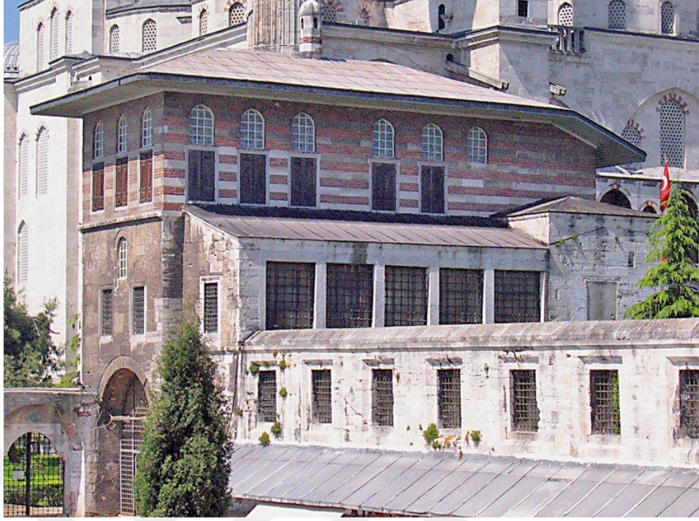
Fotoğraf 59. Sultan Ahmed Camii'nin Hünkâr Kasrı
