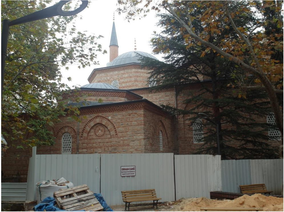
Fotoğraf 32. Bursa Orhan Camii'nin Batı Cephesi ve Yapının Beden Duvarlarında Malzeme Kullanımı
