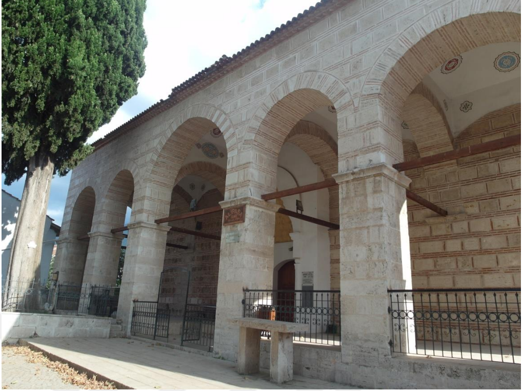
Fotoğraf 15. Bursa Ali Paşa Camii'nin Kuzey Cephesinden Genel Görüntü
