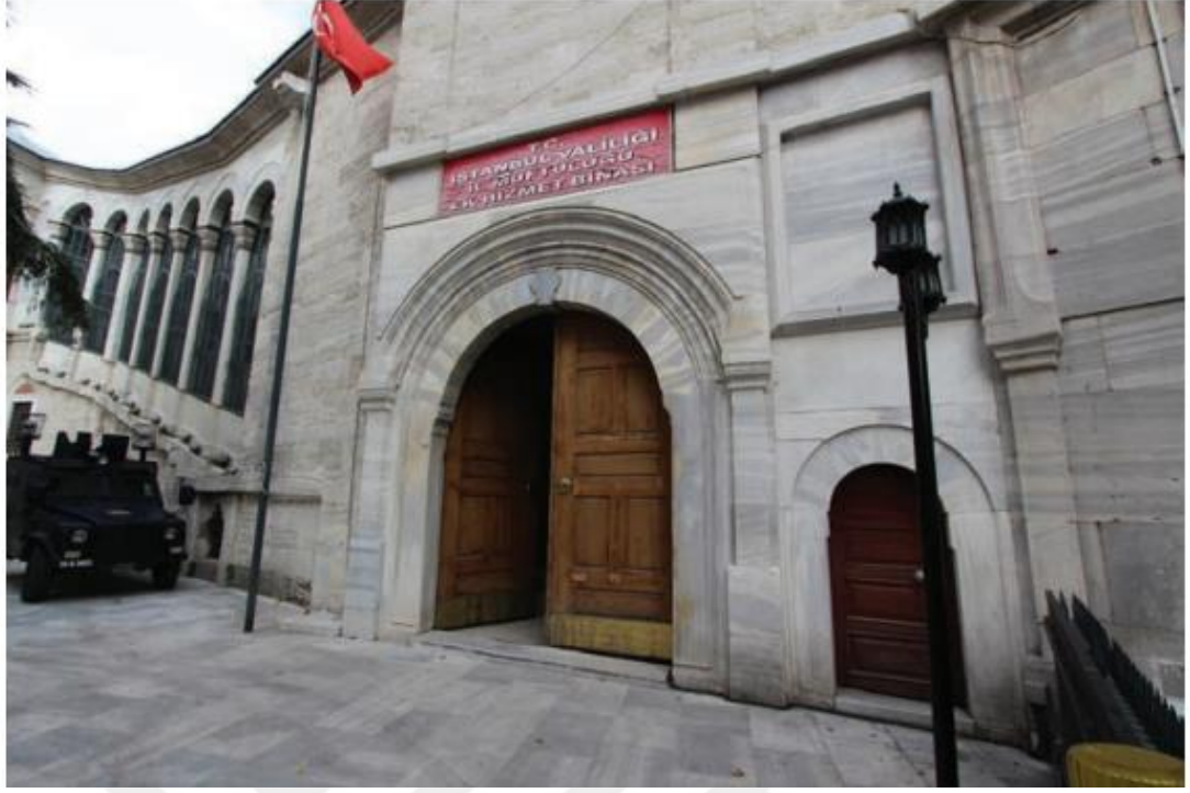
Fotoğraf 69. Nûr-ı Osmânî Camii'nin Hünkâr Kasrı Rampasının Taç Kapı Ön Yüzü Kaynak: (İnce ve Ekmekci, 2021)
