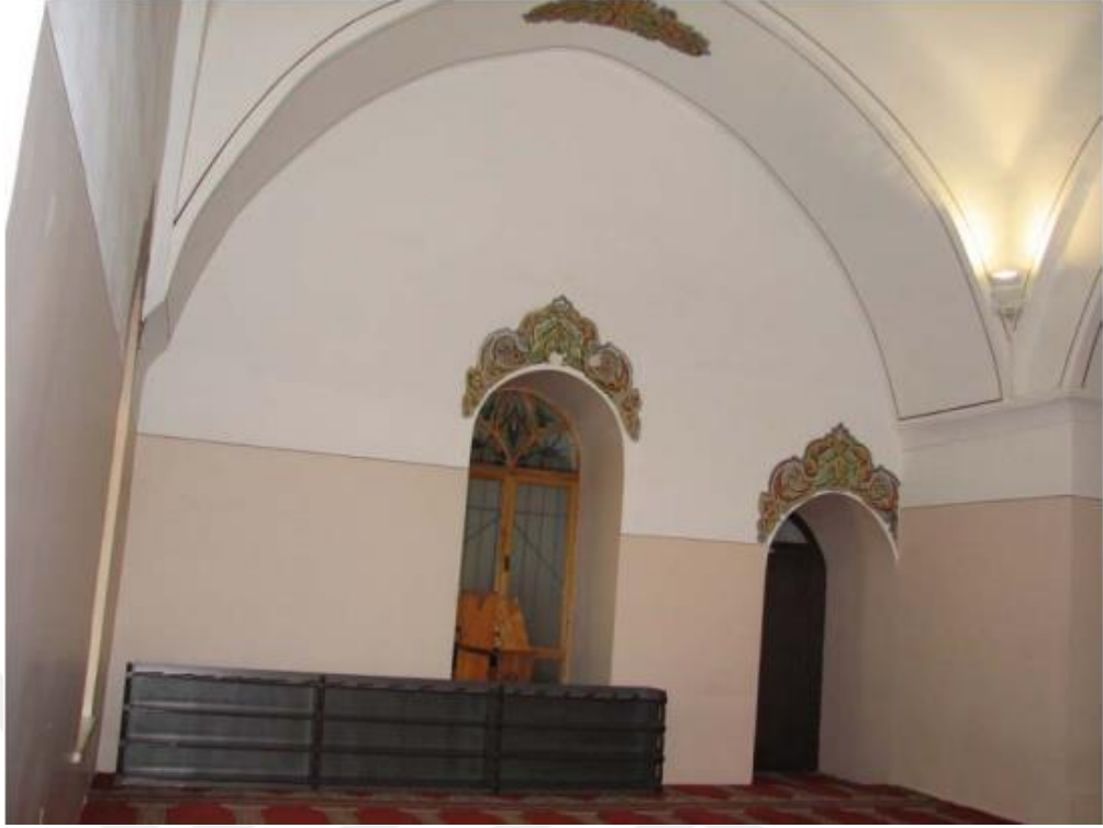
Fotoğraf 33. Bursa Orhan Camii'nin Batıdaki Tabhâne Mekânının Kuzey Duvarı Kaynak: (Acar, 2007)
