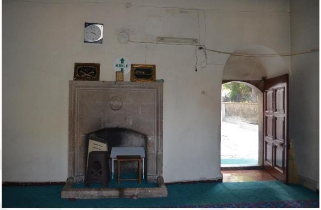
Fotoğraf 47. Afyon Gedik Ahmed Paşa Camii'nin Kuzeybatı Yönündeki Tabhâne Mekânı ve Özgünlüğünü Kaybetmiş Ocak Nişi Kaynak: (Çatalbaş, 2020)
