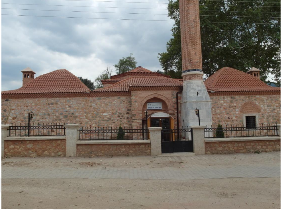
Fotoğraf 53. İnegöl Kurşunlu (Yıldırım) Cami Kuzey Cephesi
