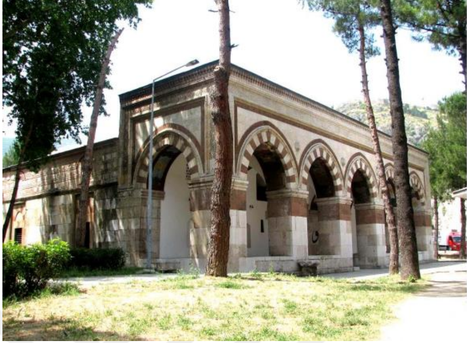
Fotoğraf 25. Amasya Bayezid Paşa Camii'nin Kuzeydoğu Cephesi Kaynak: (Acar, 2011)
