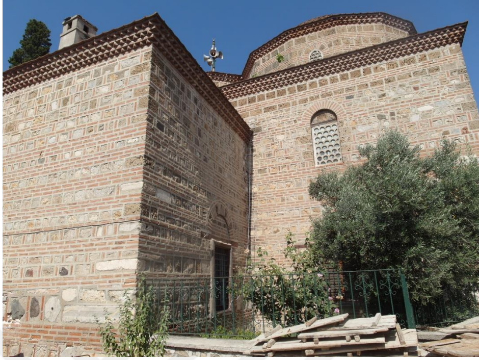
Fotoğraf 13. İznik Yâkub Çelebi Zâviyesi'nin Güneybatı Cephesinden Duvar Tekniği ve Saçak Detayı
