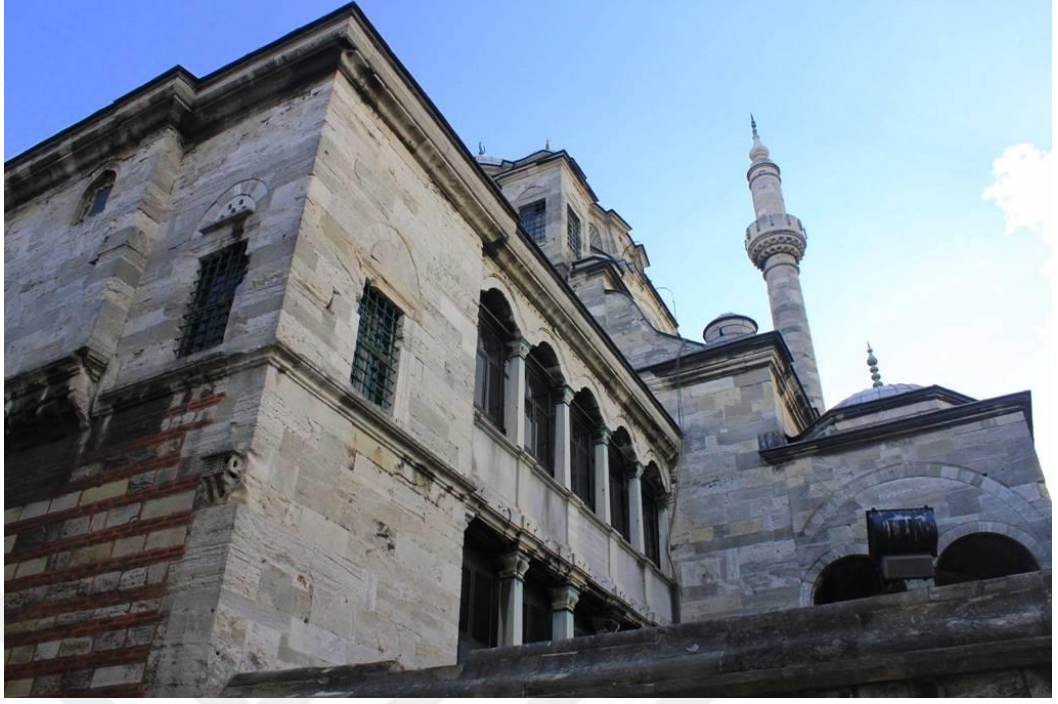
Fotoğraf 79. Ayazma Camii'nin Hünkâr Kasrı Kuzey Cephe
