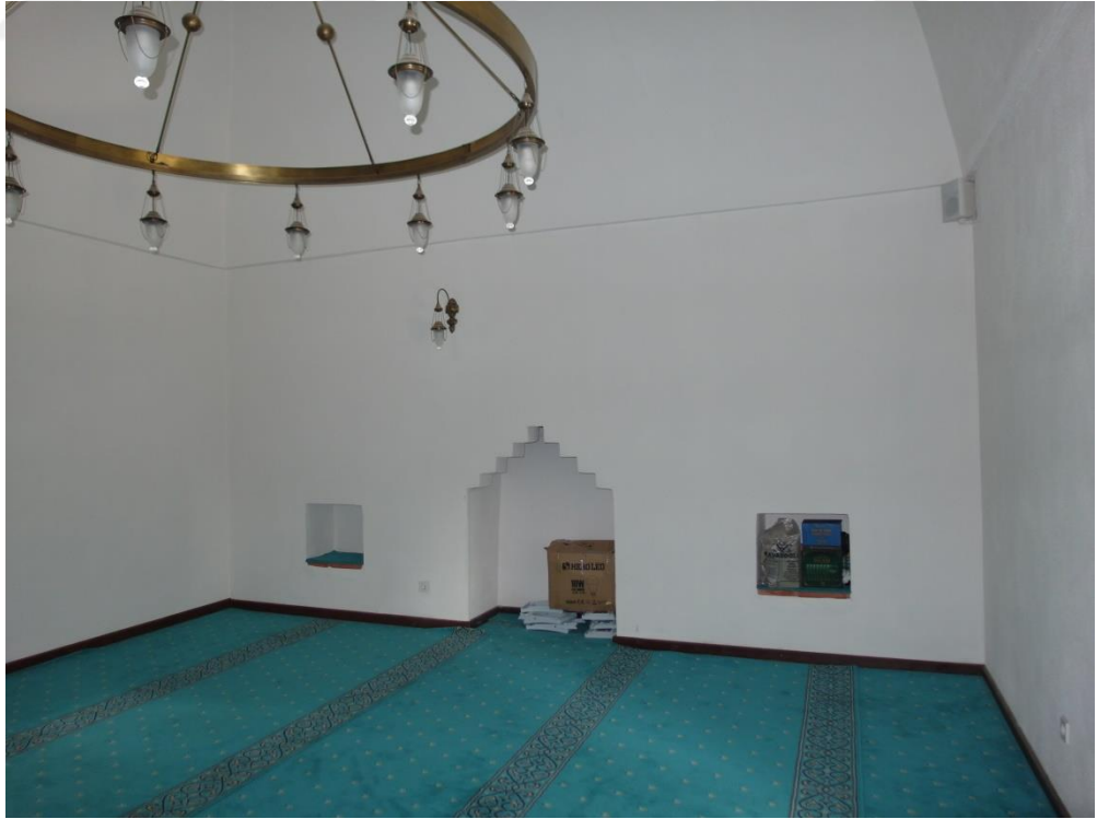
Fotoğraf 54. İnegöl Kurşunlu (Yıldırım) Cami Batıdaki Tabhâne Mekânı ile Mekânın Batı Duvarında Yer Alan Ocak ve Dolap Nişleri
