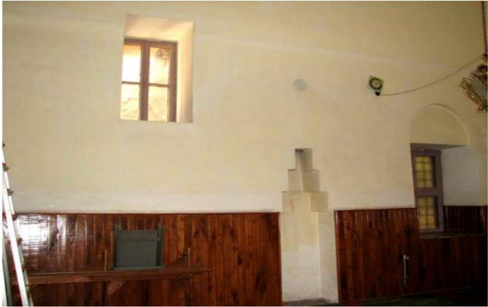
Fotoğraf 18. Bursa Ebû İshak Camii'nin Doğudaki Tabhâne Mekânının Doğru Duvarındaki Ocak Nişi Kaynak: (Acar, 2011)
